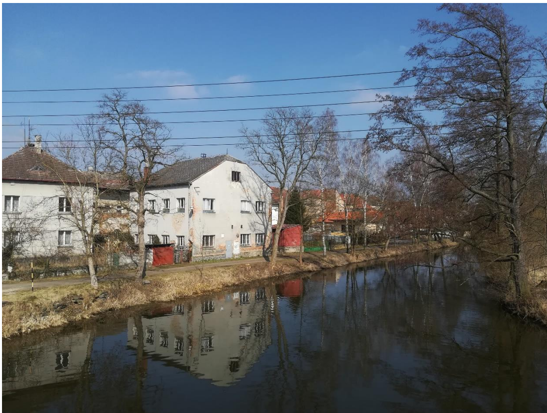
Obrázek č. 19: Budova 1
