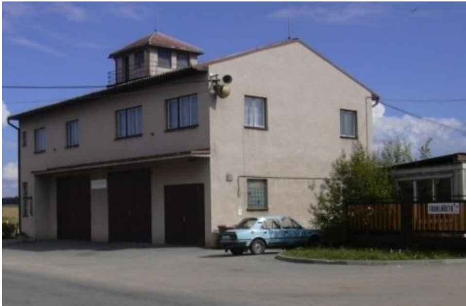
Obr. č. 5: Pohled na hasičskou zbrojnici (zdroj: www.obeczabovresky.cz )
