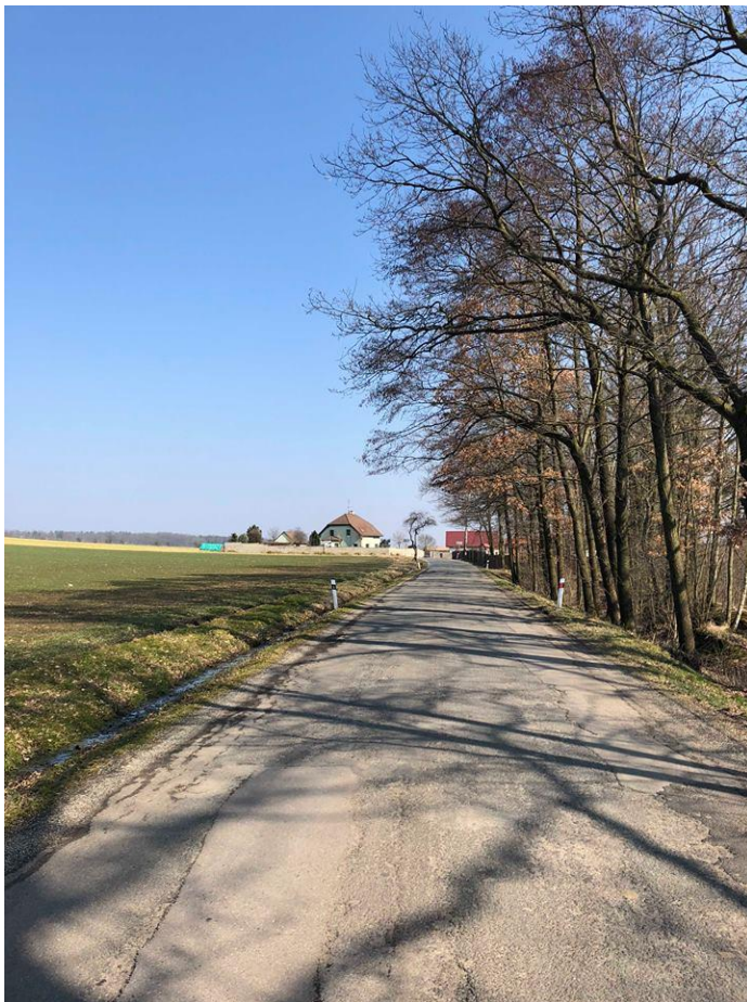
Obr. č. 18: Příjezdová cesta do Žabovřesk před rekonstrukcí (autor: Nicola Vachová)
