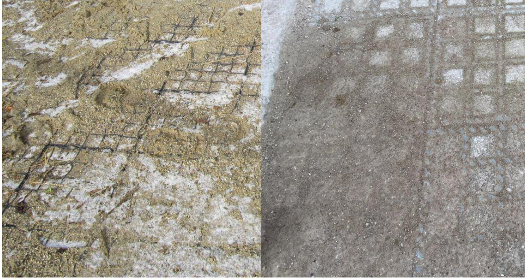
Obrázek 15: Různé způsoby zpevnění povrchů (vlevo rohože vysypané šotolinou, vpravo děrovaná dlažba)
