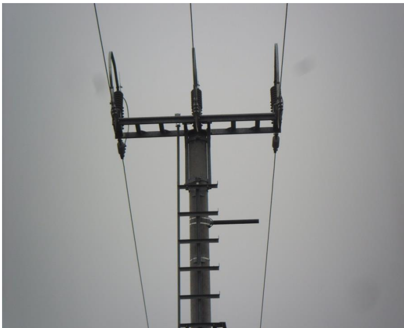
Obr. č. 9 Úprava již stávajícího sloupu instalací dosedacího bidla v krátkém provedení. Ptákům je ovšem stále umožněno, pro ptáky vysoce rizikové dosedání ze shora. Foto – autor.
