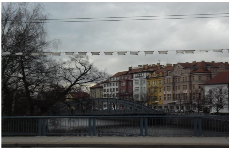
Obr. č. 1 Vizuální zvýraznění nadzemních vodičů nad řekou, které má v Českých Budějovicích za úkol varovat letící ptáky před kolizí. Foto autor.
