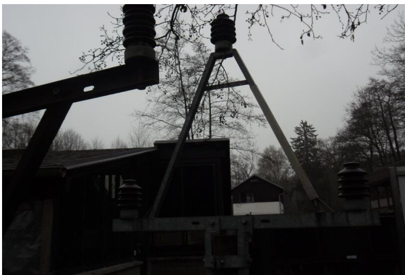
Obr. č. 7 Konzola typu Delta. V levé části patrný bílý ochranný plastový „límeč“ sloužící k izolaci. Foto autor.
