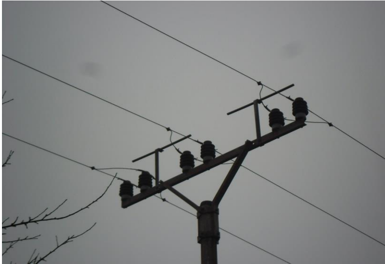
Obr. č. 5 „Lavička“ v půleném provedení. Její funkce zůstává stejná. Foto autor.
