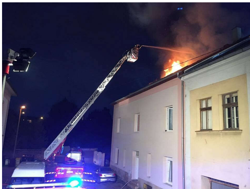
Obr. 30: Požár střechy v Plzni. Zdroj: Jakoubková, 2016
