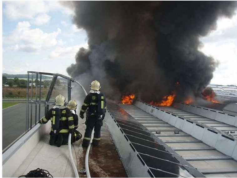
Obr. 32: Hořící střecha s FV panely.
