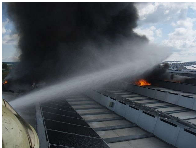
Obr. 33: Hašení FV panelů.
