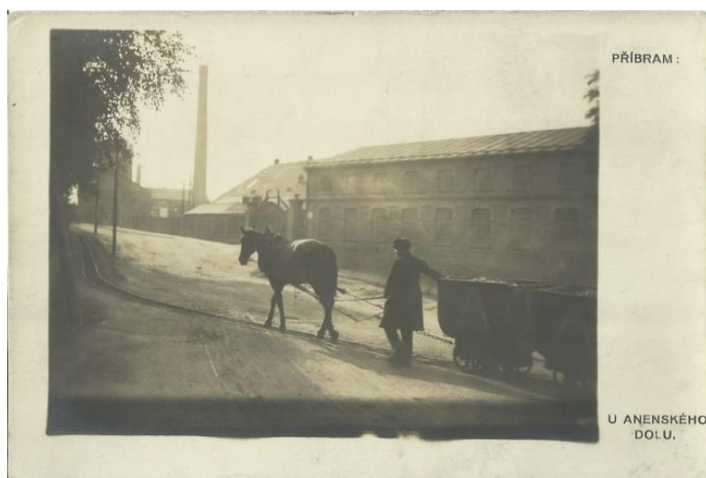
Obrázek 6: U Anenského dolu: Odvoz vytěžené rudniny pomocí koňské síly do „sypu“
