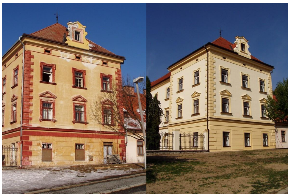
Obrázek 5: Rekonstrukce zámku Pacov
