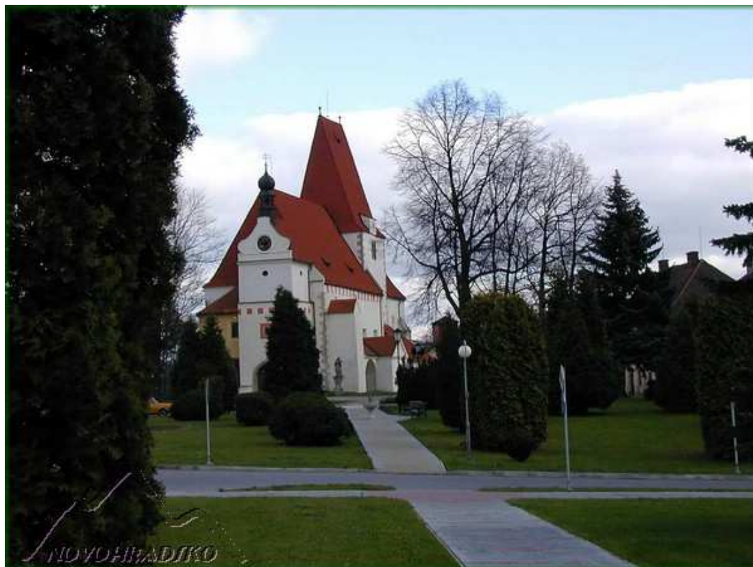
Horní Stropnice, pohled na nově opravený kostel, (zdroj: www.novohradsko.com )
