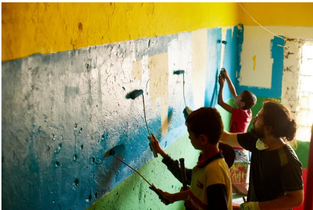
Obrázok 3 Maľovanie bytoviek, osada Hábeš, Sečovce
