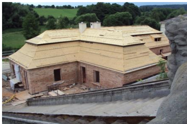
Obr. 16: Stavba mansardové střechy
