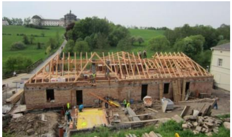
Obr. 15: Rekonstrukce lázeňského domku
