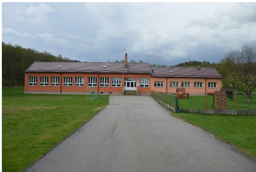
Foto 28 Tělocvična a hřiště základní školy v Nové Včelnici (zdroj: vlastní foto)
