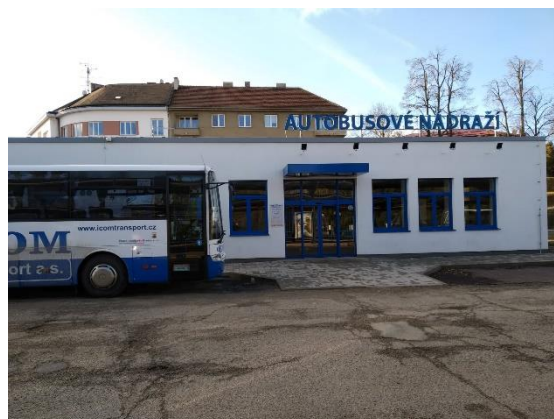
Foto 5 Hlavní budova autobusového nádraží Dačice
