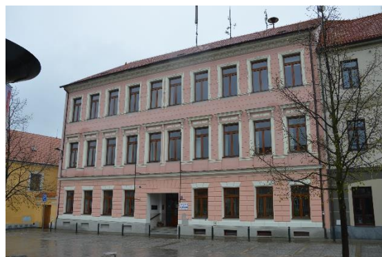
Foto 30 Základní škola a mateřská škola Lomnice n. Lužnicí (zdroj: vlastní foto)
