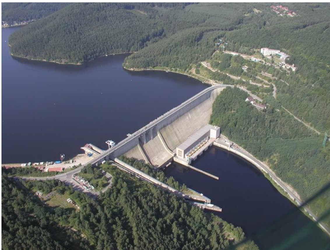
Obrázek 3.2: Vodní elektrárna Orlík [104]
