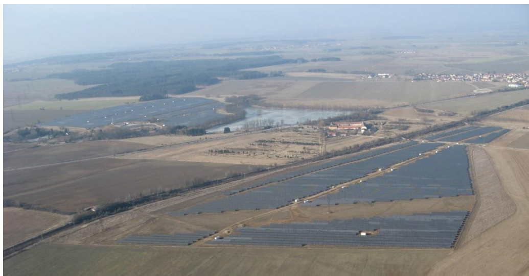
Obrázek 3.3: Fotovoltaická elektrárna Ševětín [67]
