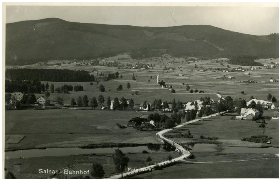
Obr. 26 Dochovaná fotografie mostu u Nové Pece
