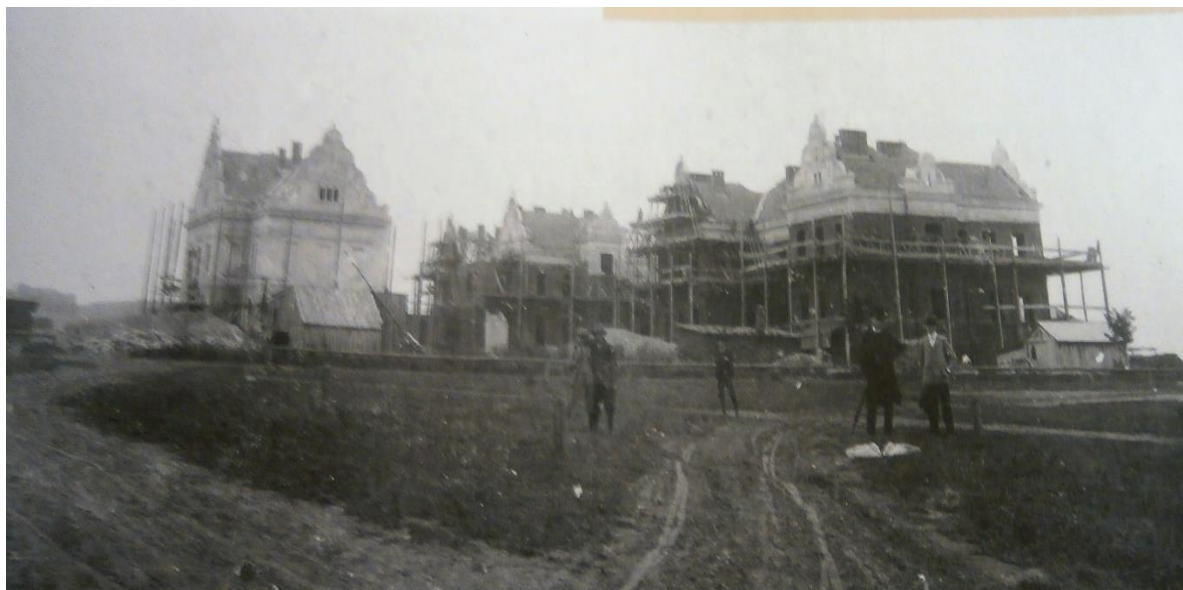
Obr. 1 – Stavba nemocnice 1909 (Zdroj: Prášek J., 2017)
