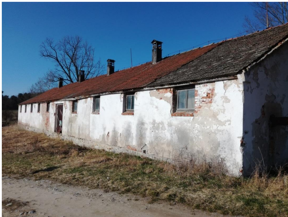
Obrázek 15: Pohled na střešní krytinu
