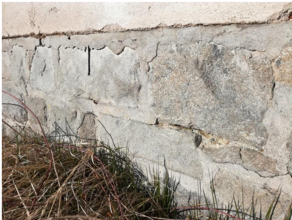
Obrázek 11: Pohled na základy
