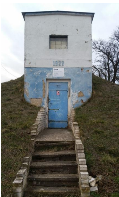
Obr. č. 49: vodojem
