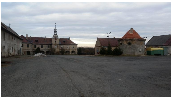
Obr. č. 23: zámek s poplužním dvorem a studnou
