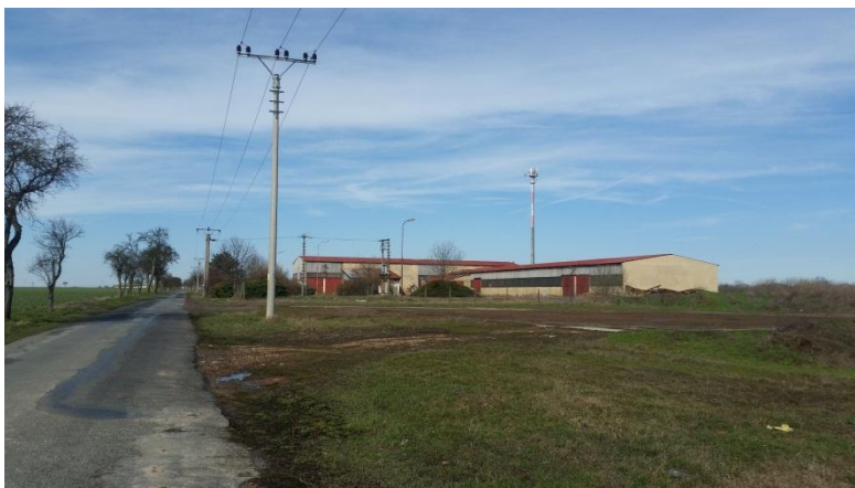
Obr. č. 51: areál zemědělské výroby se stožárem vysílače
