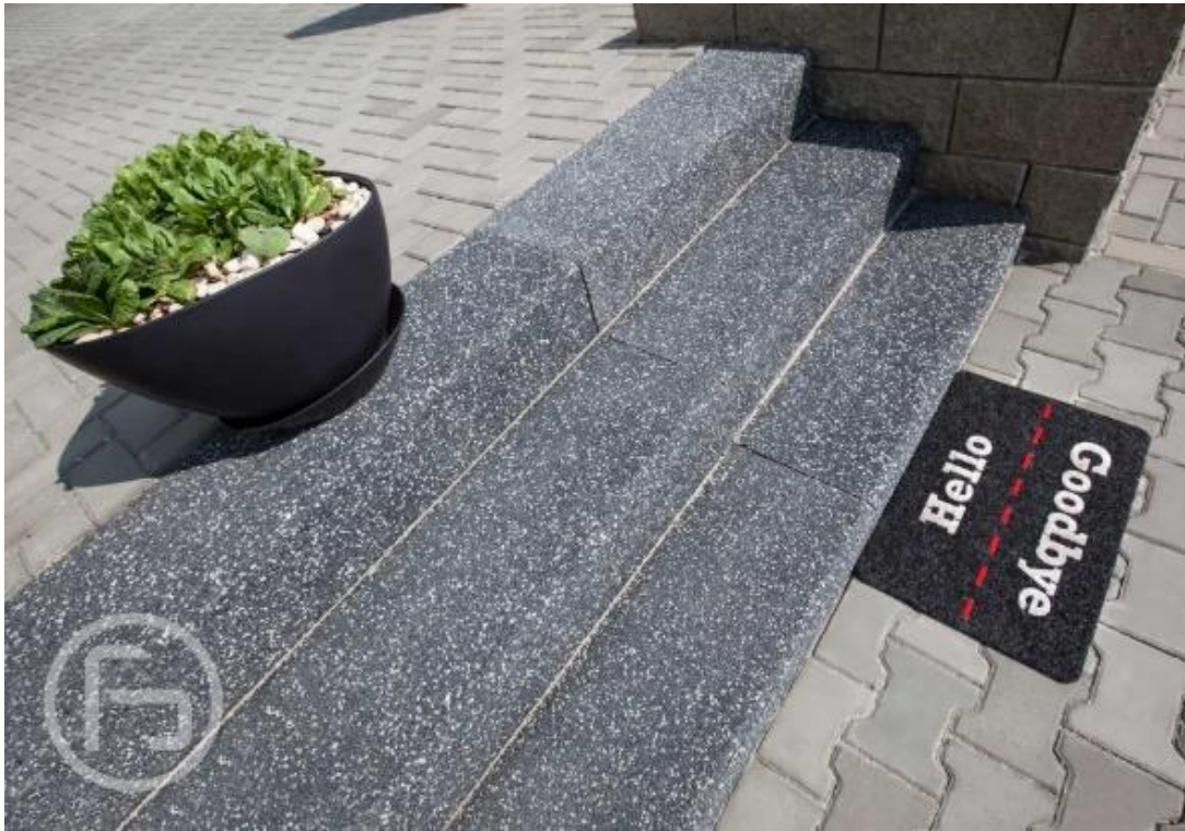
Fotografie č. 33 Nově navržený typ schodiště
