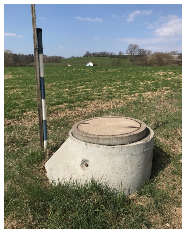
Obrázek 33: Kontrolní místo odvodňovací stavby (vlastní foto).
