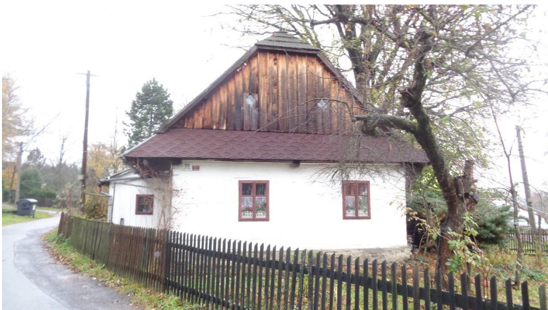
Obrázek 36 - Usedlost v obci Křižánky (Zdroj: autor)
