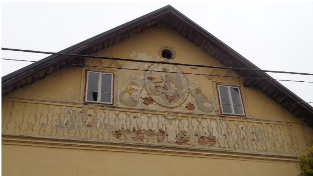
Obrázek 22 - Usedlost č. p. 39, detail štukové výzdoby (Zdroj: autor)
