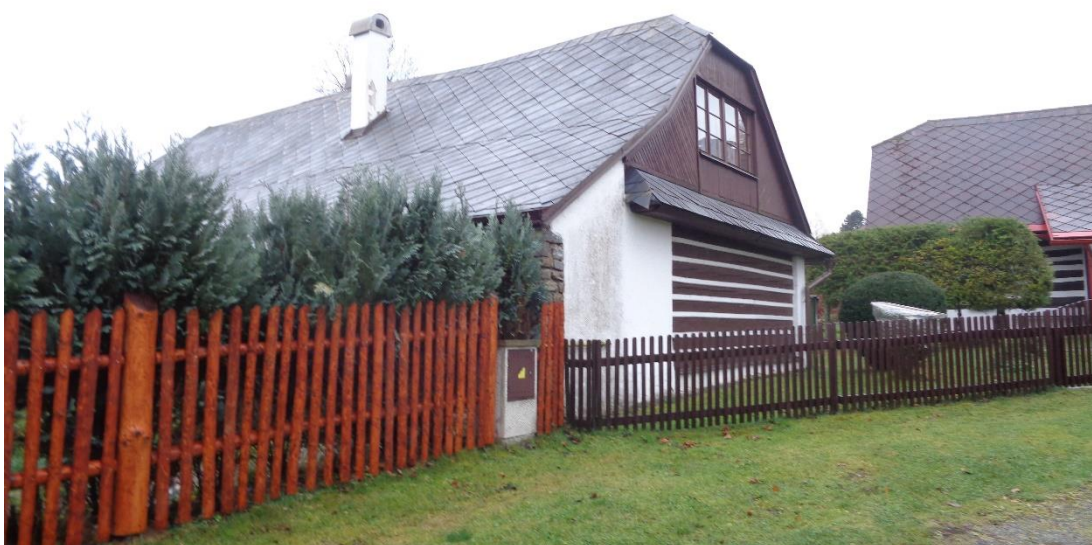
Obrázek 35 - Usedlost v obci Křižánky (Zdroj: autor)
