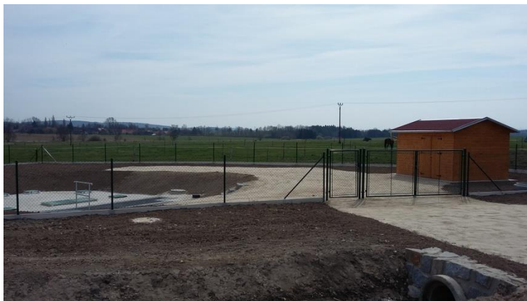
Obrázek č. 12: Centrální čistírna odpadních vod v obci Lhota pod Horami
