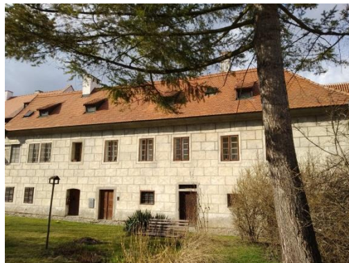
Foto autora č. 10 Budova panského pivovaru na nádvoří Státního zámku Český Krumlov
