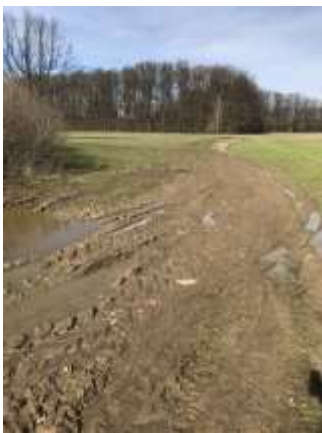
Obr. 5 Nefunkční odvodnění, dochází k vytvoření vodní hladiny
