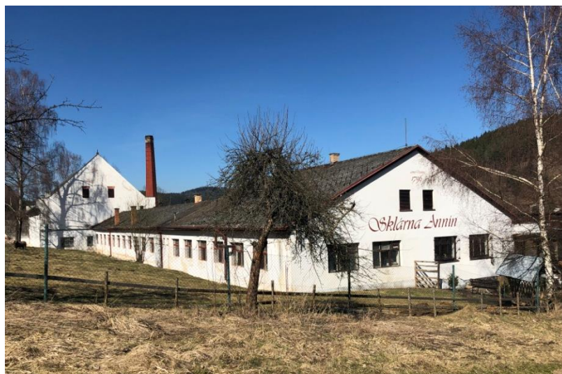
obr. č. 14 Pohled na sklárnu Annín
