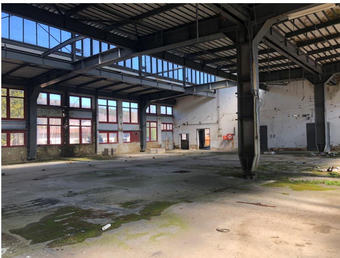
obr. č. 11 Pohled na halu uvnitř sklárny Lenora
