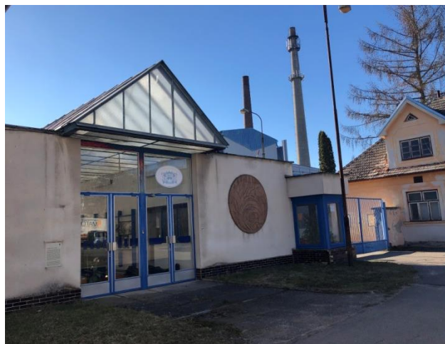
obr. č. 5 Pohled na vstupní halu sklárny v Chlumu u Třeboně
