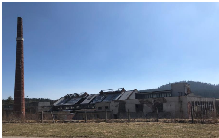
obr. č. 8 Pohled na sklárnu v Lenoře
