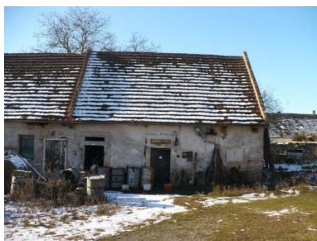
Obrázek 29: Objekt pivovaru před rekonstrukcí
