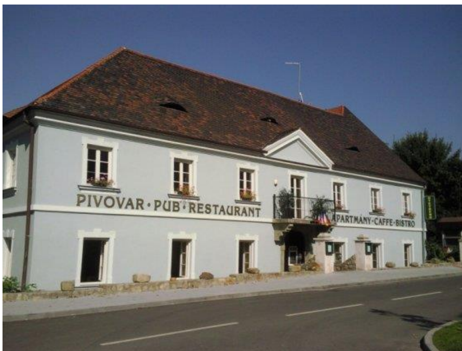
Obrázek 6: Budova minipivovaru po rekonstrukci
