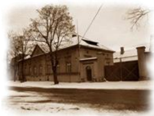
Obrázek 24: Původní budova Pivovaru Purkmistr
