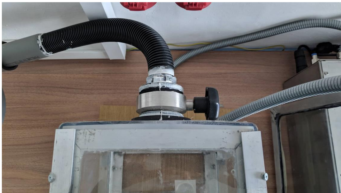
Obrázek č. 13: Spodní otvor odvětrávání komory s nainstalovaným regulačním ventilem a pružnou trubicí
