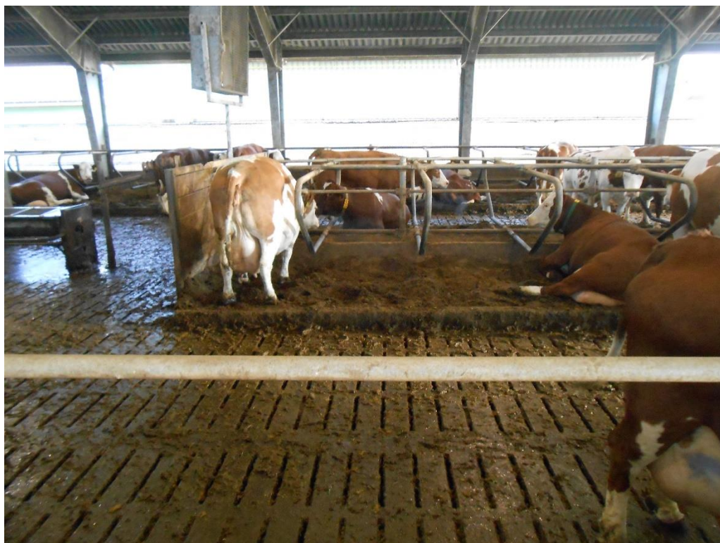
Obrázek 15 – Roštová podlaha s lehacími boxy v Nových Dvorech
