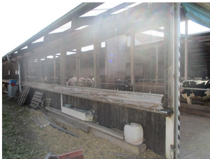
Obrázek č. 5 - Boční stěna stáje
