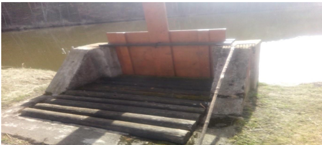
Obr. č. 5: Výpustné zařízení stavidlové
