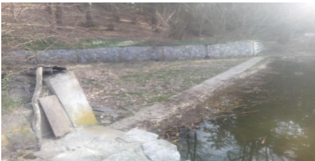
Obr. č. 9: Bezpečnostní přeliv
