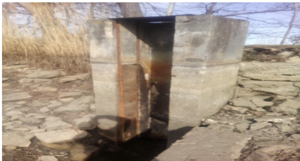
Obr. č. 8: Betonový požerák
