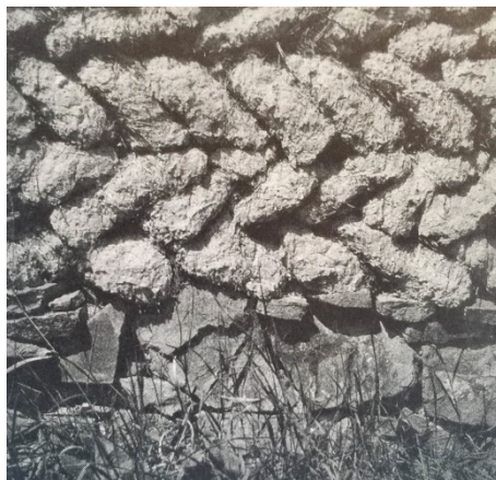
Obr. č. 3 – Stěna z hliněných válků kladených klasově (Škabrada, 1999)
