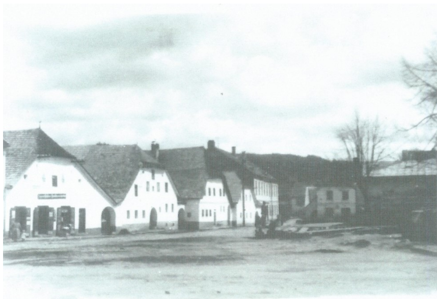
Obr. č. 15 – Část domů, které shořely (Obecní archiv)
