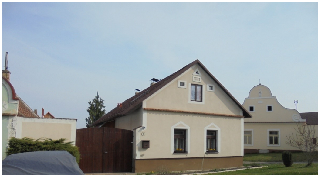
Obr. č. 54 – Přistavěná obytná část k domu s č. p. 6 (autor, 2019)
