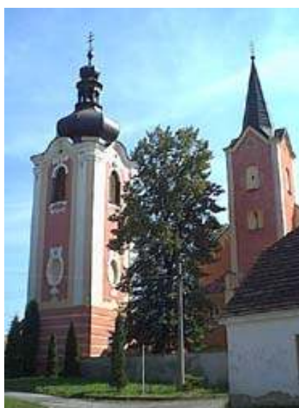
Obr.10 :Kostel sv. Jiljí v Miroticích
