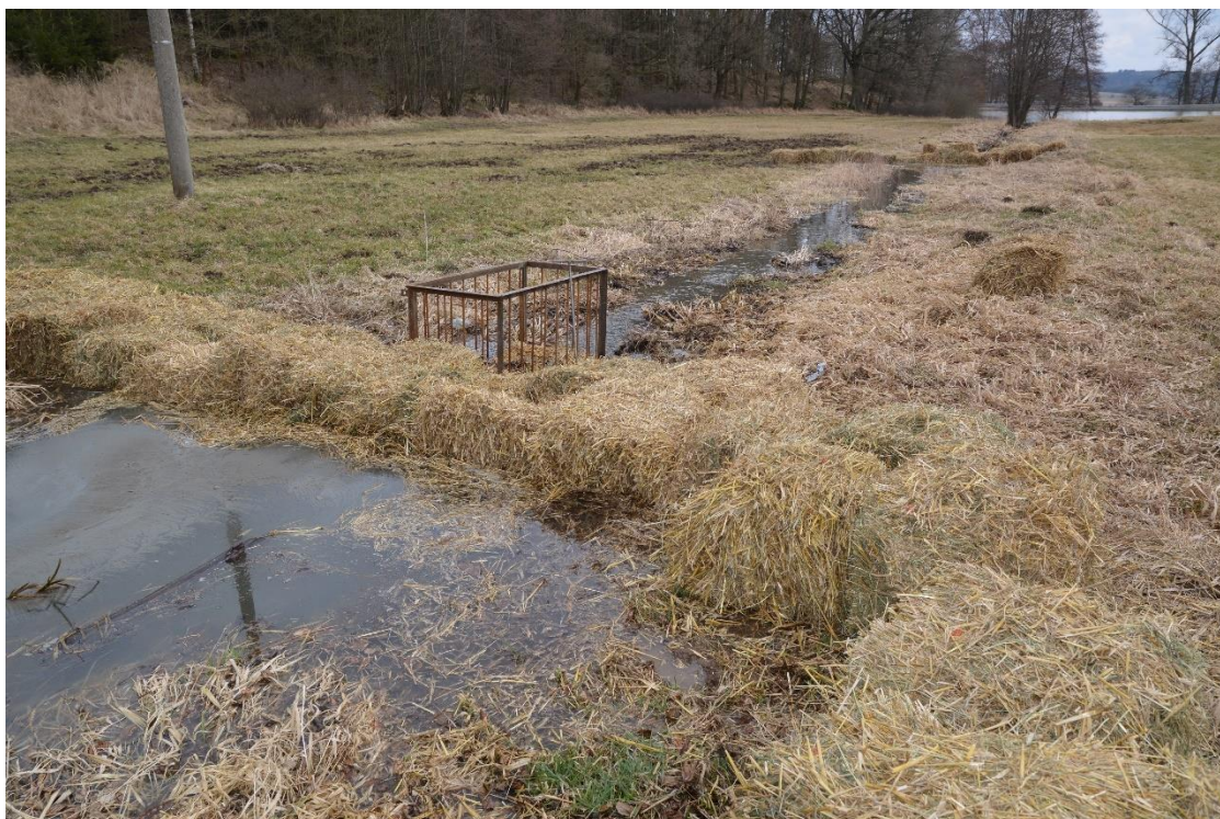
Obrázek 10 První bariera a vystavěná „křídla“ po stranách bariery pro usměrnění proudu a zvýšení objemu mezi bariery – Brdský rybník (Foto – Ján Regenda)
