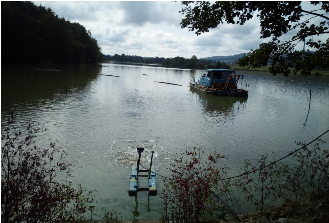
Obr. č. 1. Sací bagr při práci na rybníce – Dlouhý u Čakovce (foto: J. Dofek)
