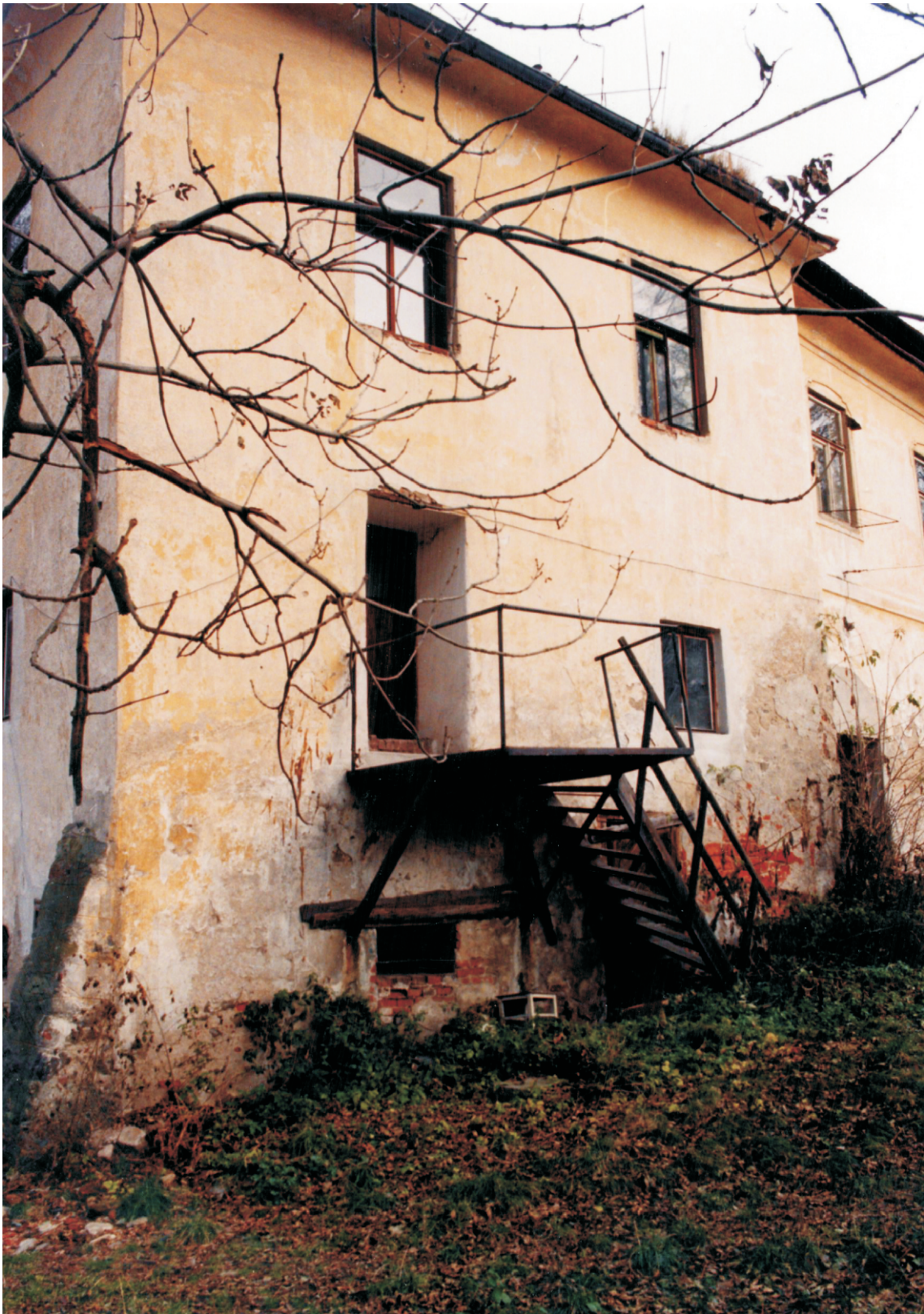
Obr. 7. Jižní fasáda jižního křídla, detail užší, předstupující části – stav z r. 1997.
