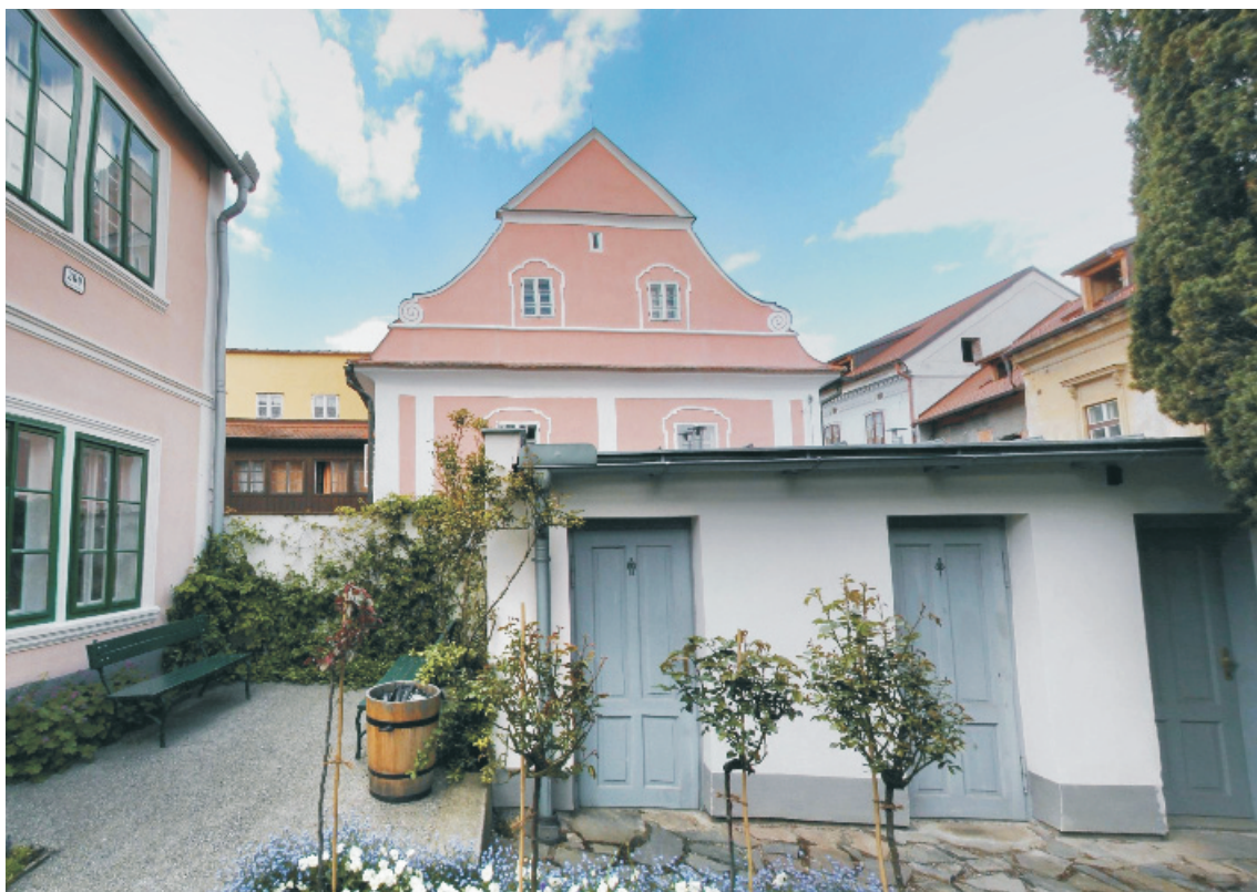
Obr. 34. Dům v Linecké č. p. 54 – současný stav.
