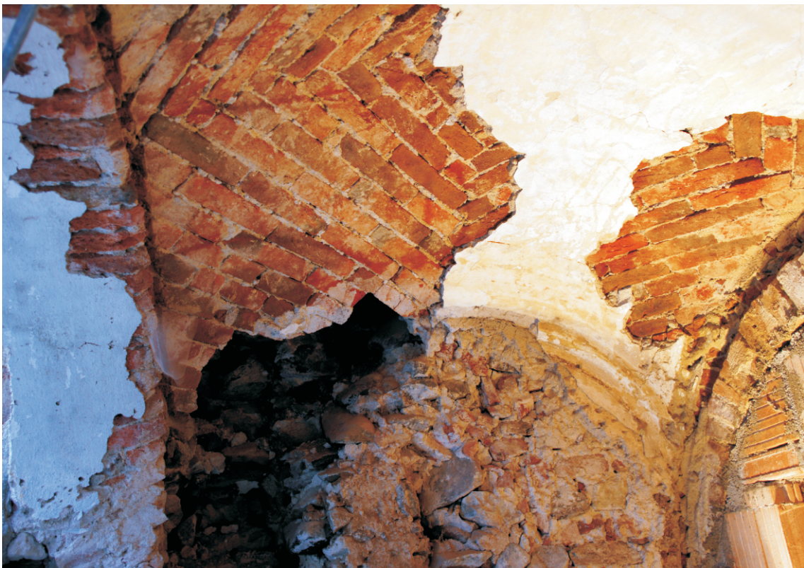
Obr. 22. Fragmenty interiéroových omítek doporučené ke konzervaci – stav 21. 9. 2018.
