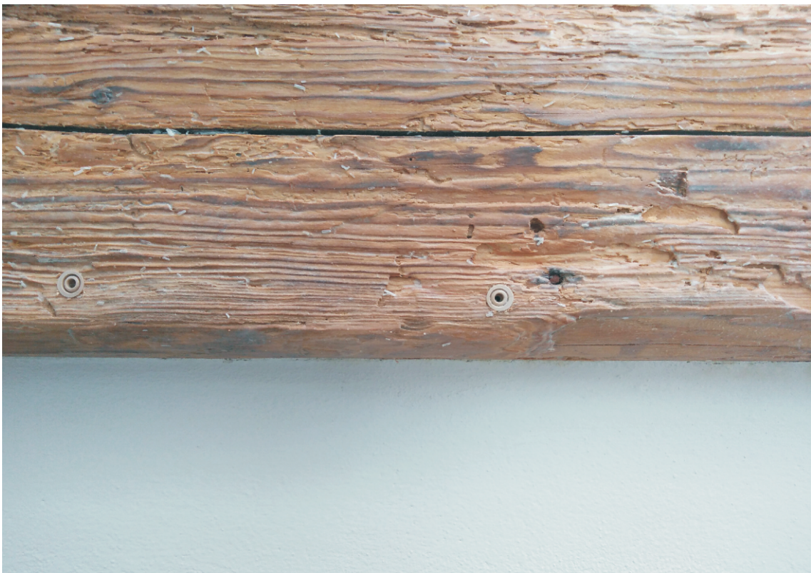
Obr. 40. Detailní pohled na zakonzervované části historického krovu.
