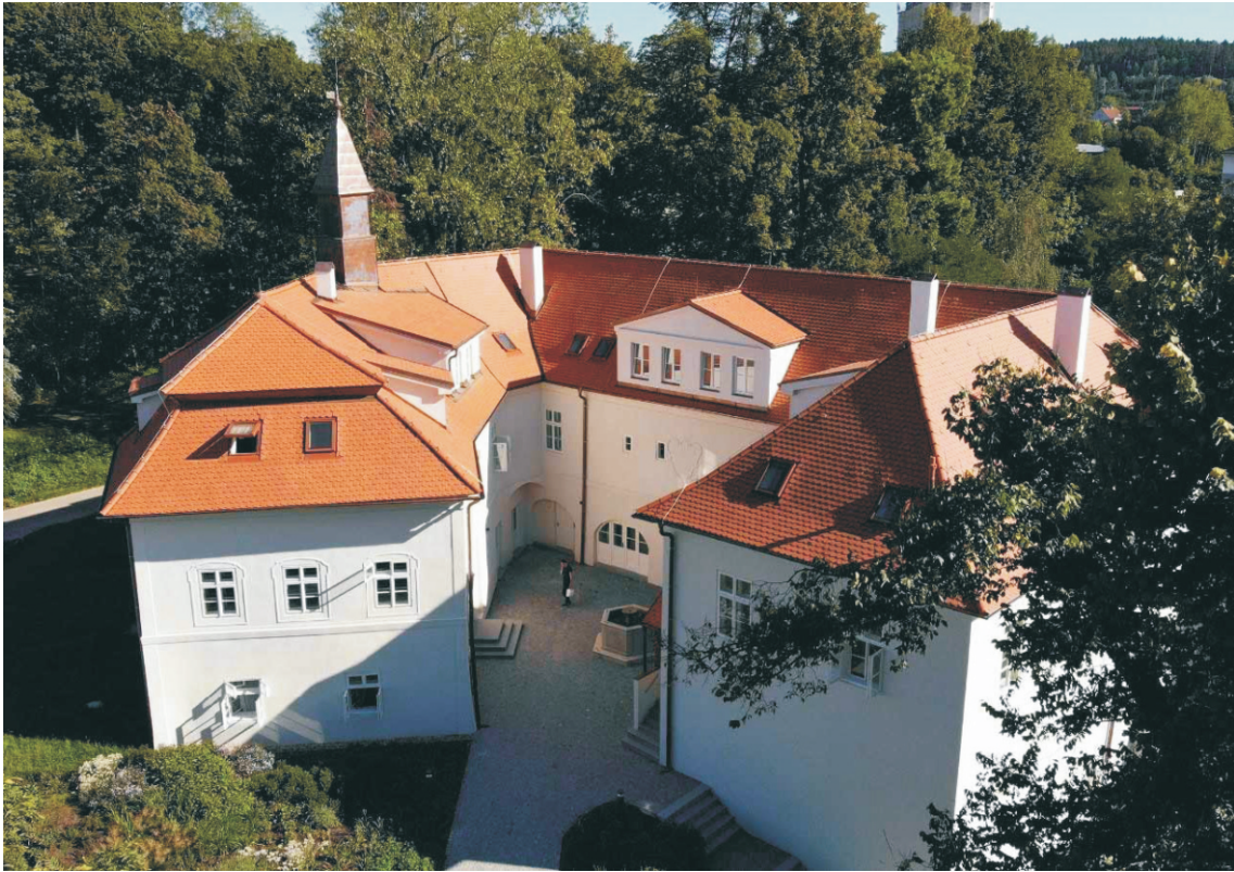
Obr. 35. Celkový pohled na zámek po rekonstrukci.
