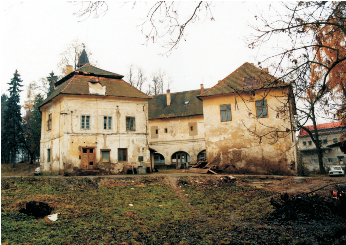
Obr. 3. Čelní pohled na zámek – stav z r. 1997.
