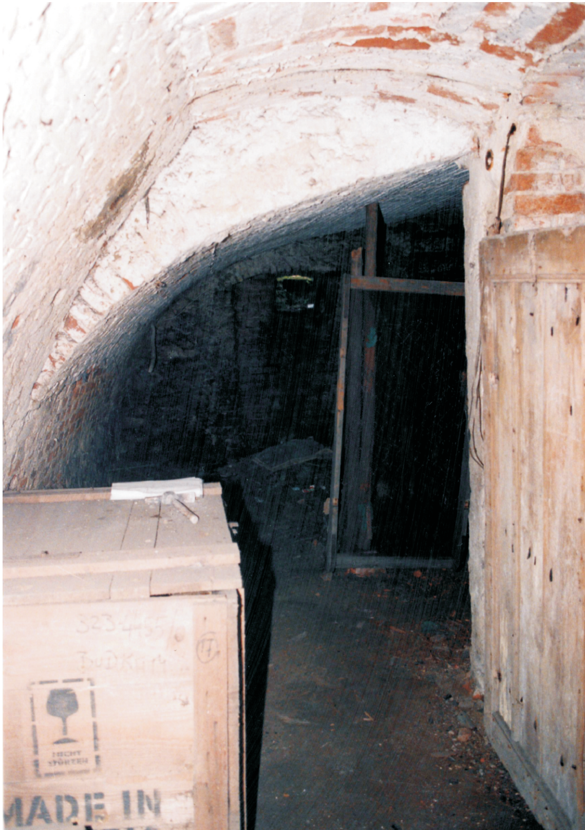
Obr. 26 Sklep pod východním křídlem – stav z r. 1997.
