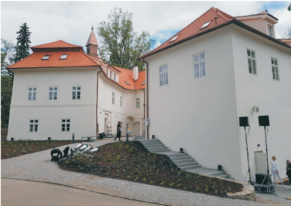
Obr. 37. Pohled na zámek po rekonstrukci – průčelí a okolní terén.
