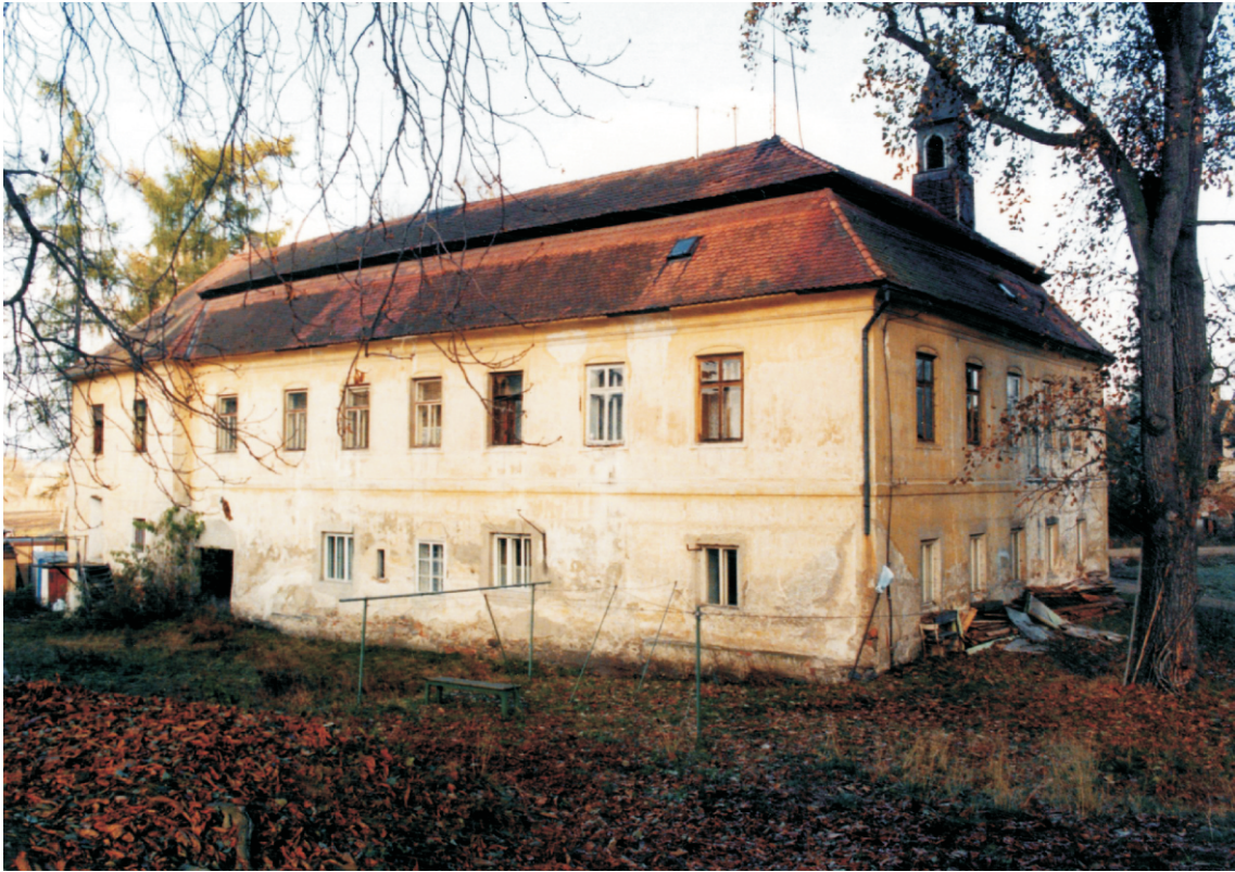
Obr. 5. Jižní fasáda jižního křídla – stav z r. 1997.
