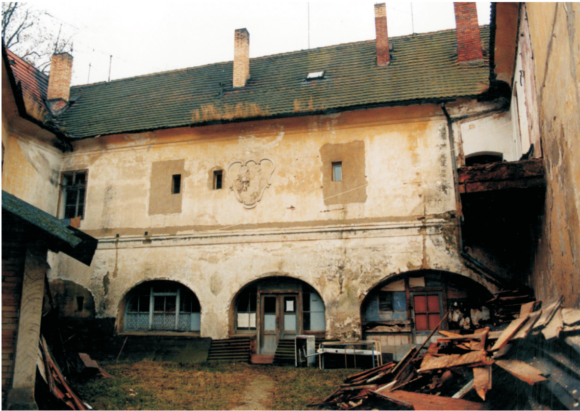
Obr. 10. Nádvořní strana jižního křídla – stav z r. 1997.
