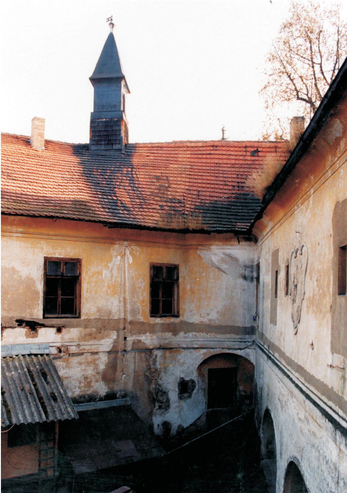
Obr. 12. Nádvoří fasáda východního křídla – stav z r. 1997.
