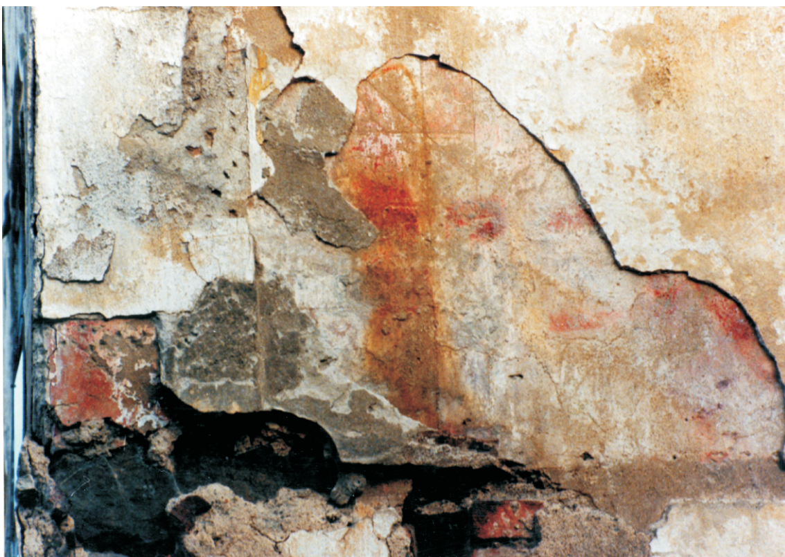
Obr. 31. Diamantování na nároží východního křídla – stav z r. 1997.
