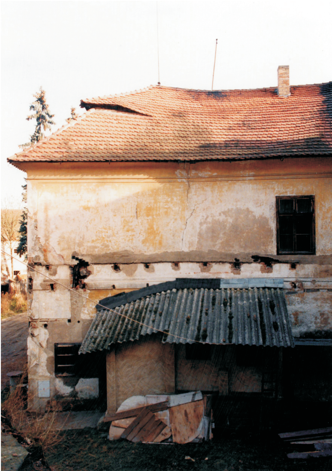
Obr. 13. Nádvořní fasáda východního křídla, část s přístavky – stav z r. 1997.
