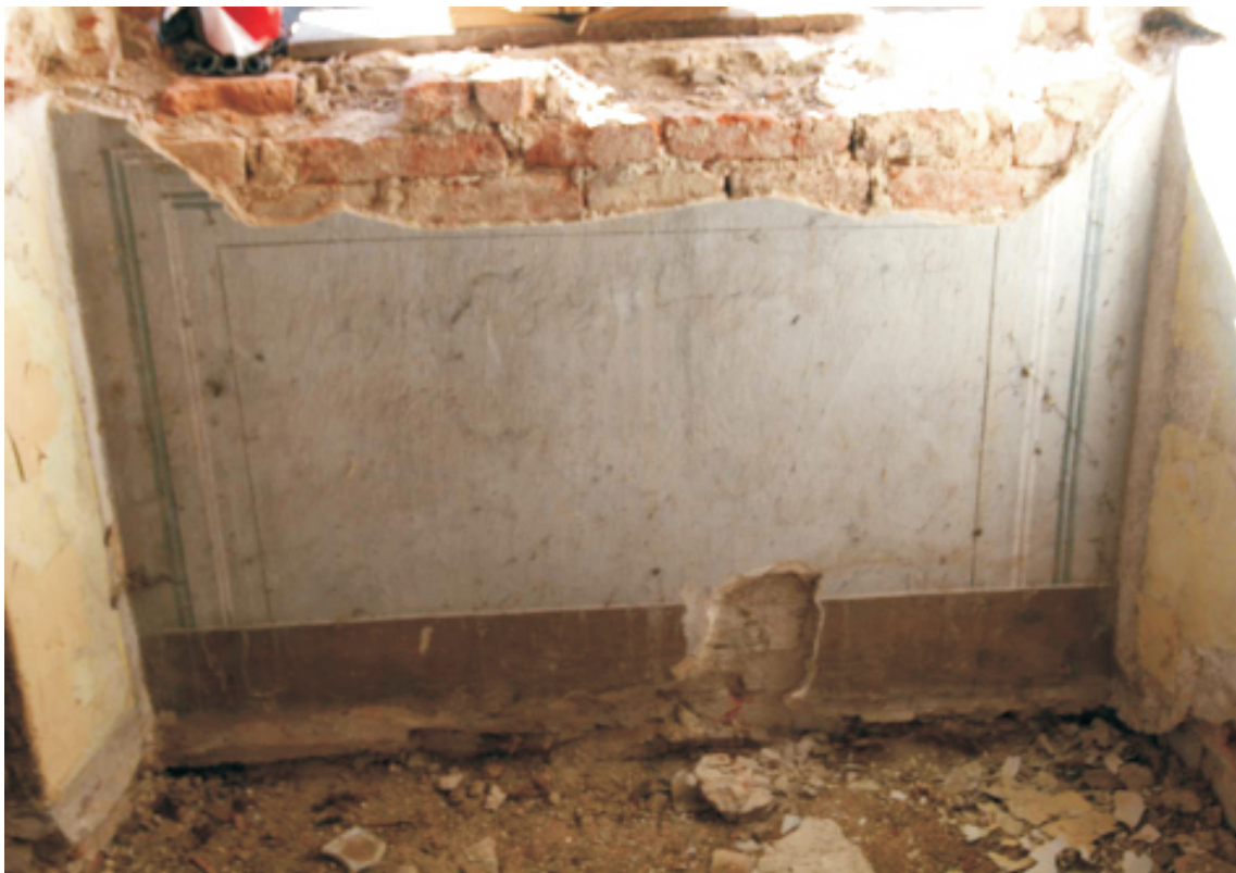
Obr. 17. Dekor omítek v interiéru – kazety ve špaletě pod oknem.
