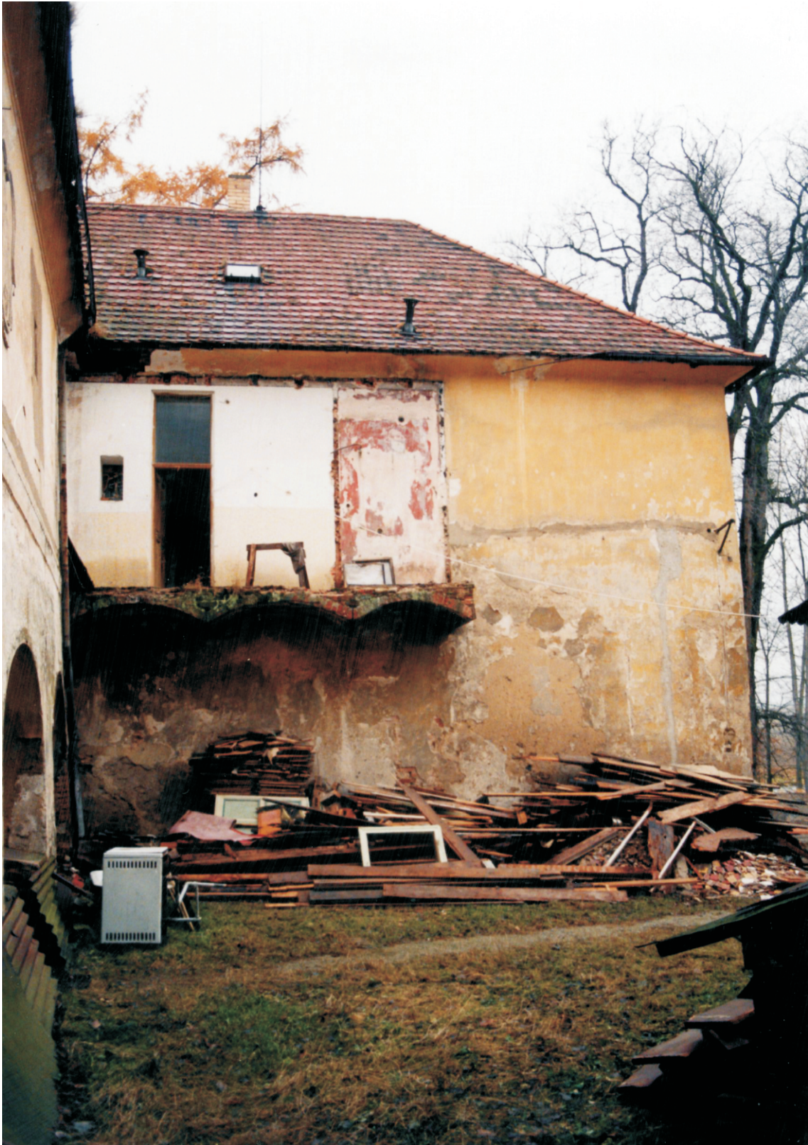
Obr. 9. Nádvoří strana západního křídla – stav z r. 1997.
