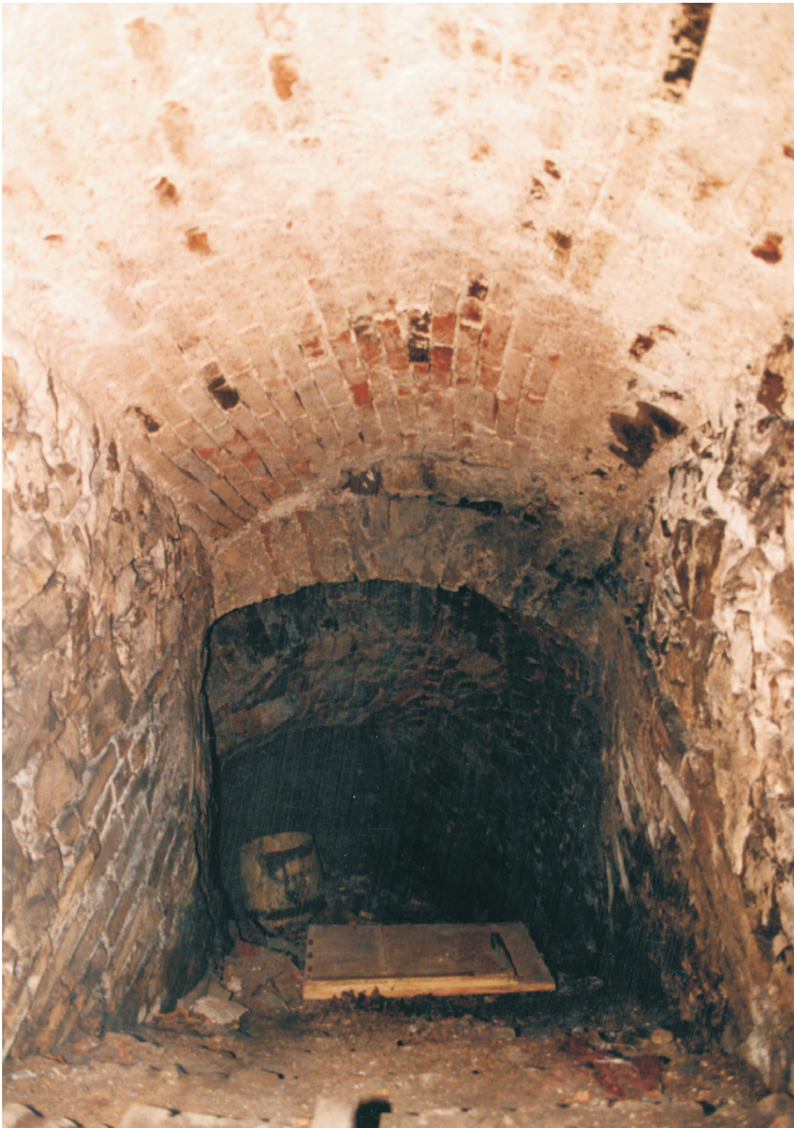
Obr. 27. Sklep pod východním křídlem – stav z r. 1997.
