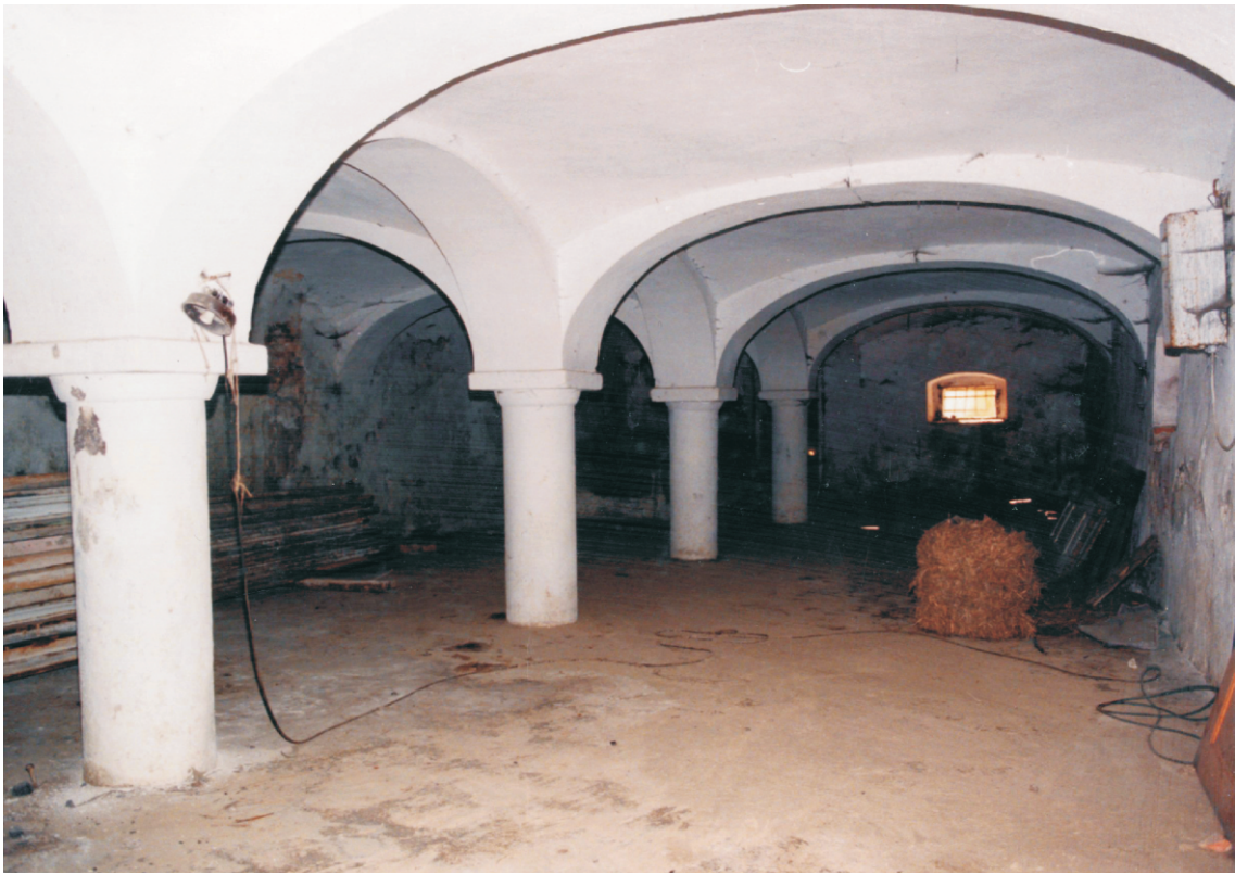
Obr. 19. Západní křídlo, sklep – stav z r. 1997.
