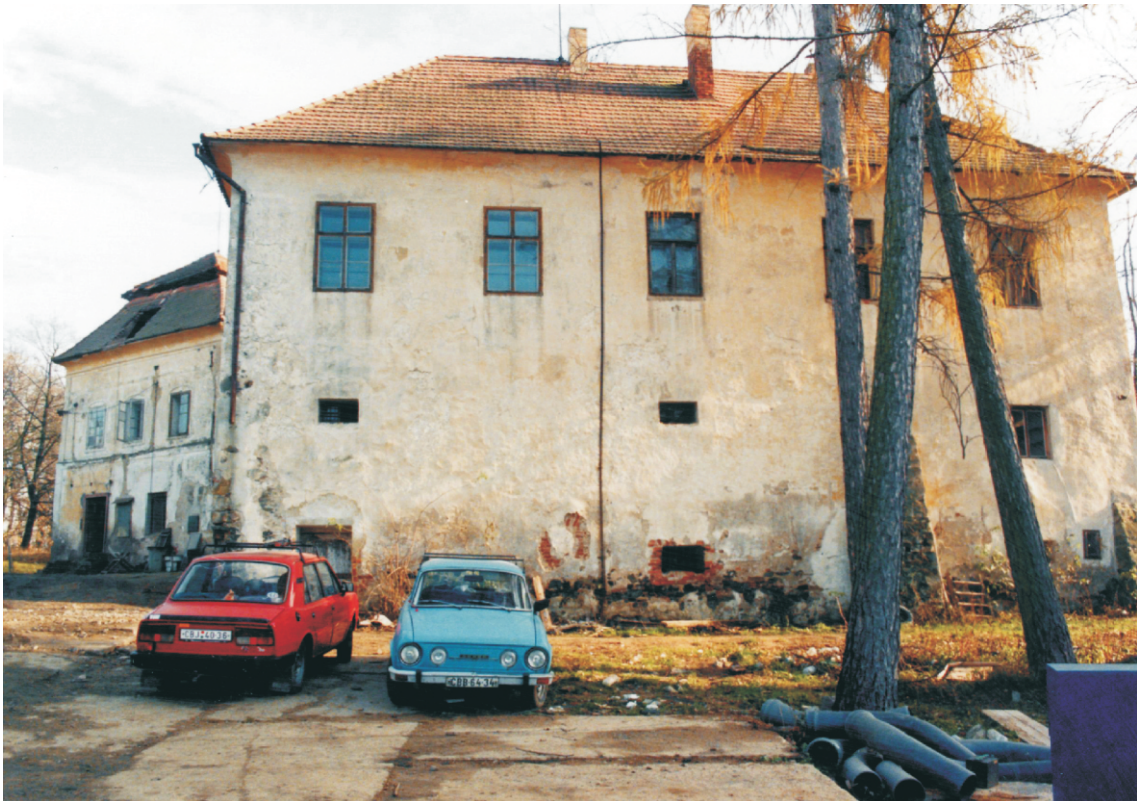
Obr. 6. Západní fasáda západního křídla – stav z r. 1997.
