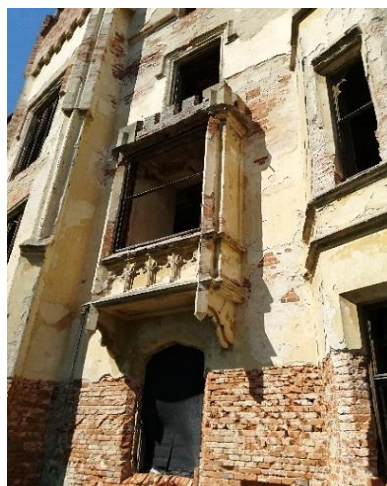
Obr. 91 Arkýř na jižním průčelí. Foto: Eva Smržová (2019).
