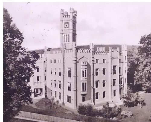
Obr. 92 Výřez pohlednice s jihozápadní nárožím. Zdroj: Starepohlednice.cz.
