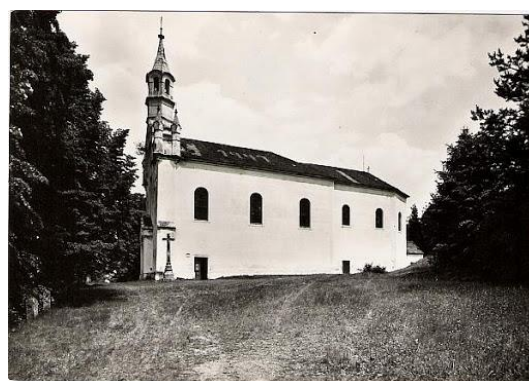
Obr. 74 Pohled na kostel od jihu. Zdroj: Slavonice-zlabings.eu.
