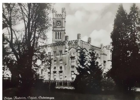
Obr. 78 Pohled na zámek od jihozápadu s viditelným nárožím přistavěným v baroku. Zdroj: Starepohlednice.cz.
