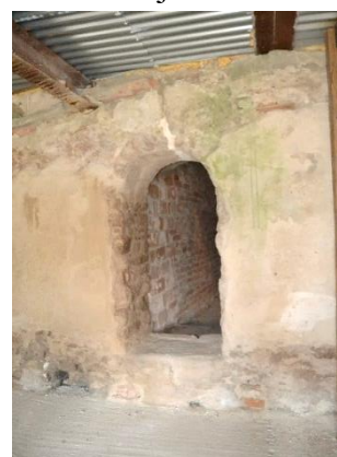
Obr. 33 Portálek dochovaný ve zdi zámecké věže na severozápadní straně. Foto: Eva Smržová (2018).
