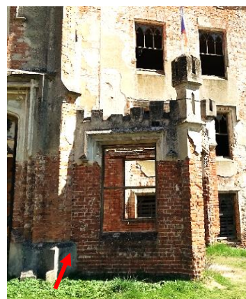
Obr. 82 Detail předělu mezi hlavní hmotou rizalitu a přiloženým křídlem. Foto: Eva Smržová (2018).
