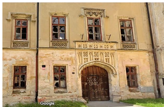
Obr. 72 Východní průčelí důstojnického pavilonu se vstupní branou. Zdroj: Googlemaps.
