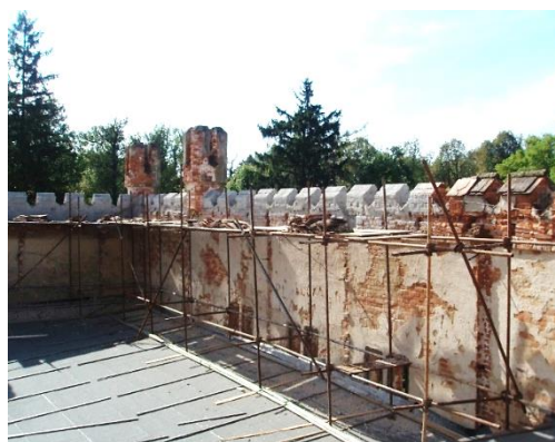
Obr. 120 Oprava cimbuří v roce 2009. Zdroj: Zamek-cesky-rudolec.cz.
