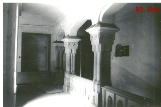
Obr. 104 Kamenné zábradlí u schodiště v prvním patře 80. letech 20. století. Zdroj: Zamek-cesky-rudolec.cz.
