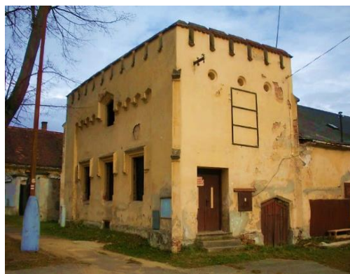
Obr. 10 Dům správce před opravou. Zdroj: Malahluboka.cz.
