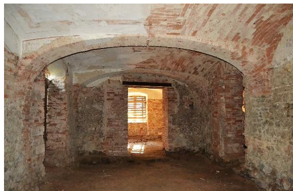
Obr. 53 Přízemní místnosti zámku v jižním traktu. Foto: Eva Smržová (2018).
