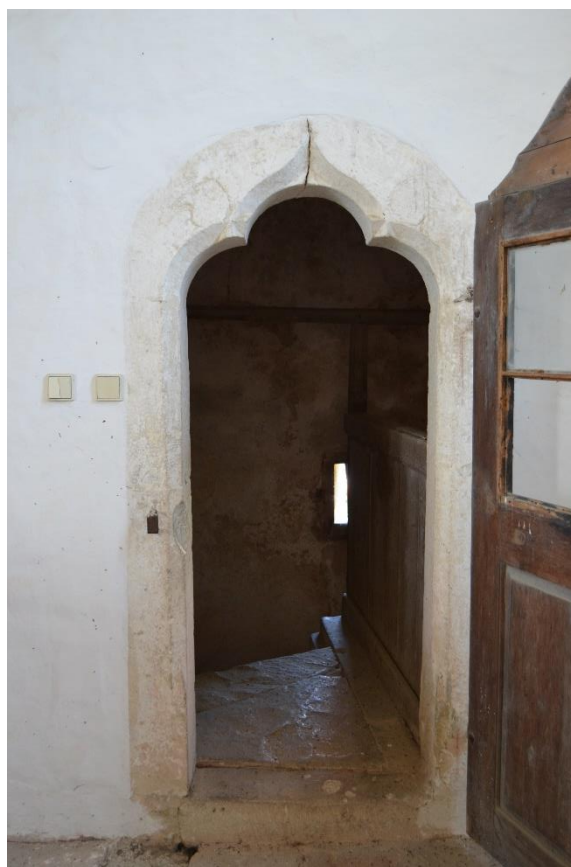
Obr. 32 – Kruchta, pohled na ostění portálu kruchty.
