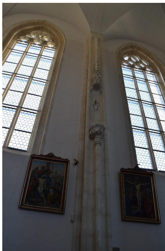
Obr. 21 – Interiér trojloží, pohled na příporu boční lodi s konzolí a baldachýnem.
