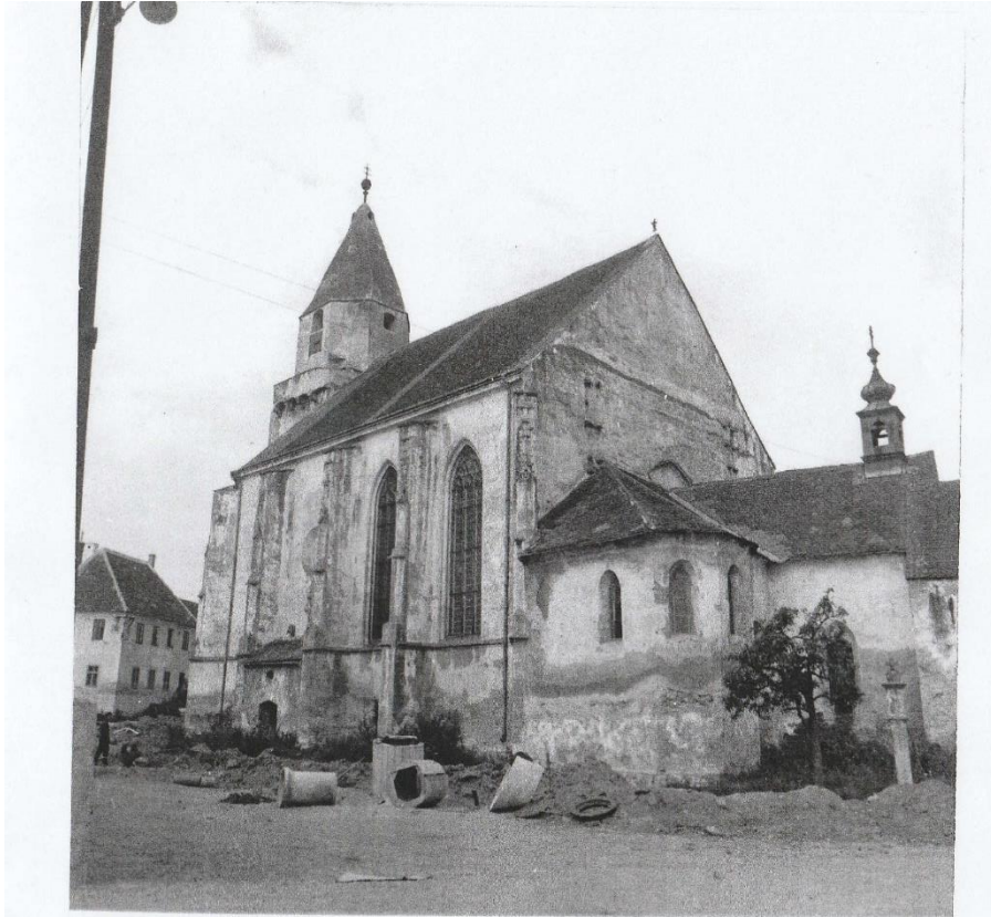
Obr. 50 – Exteriér kostela, pohled z jihu, dobová fotografie.
