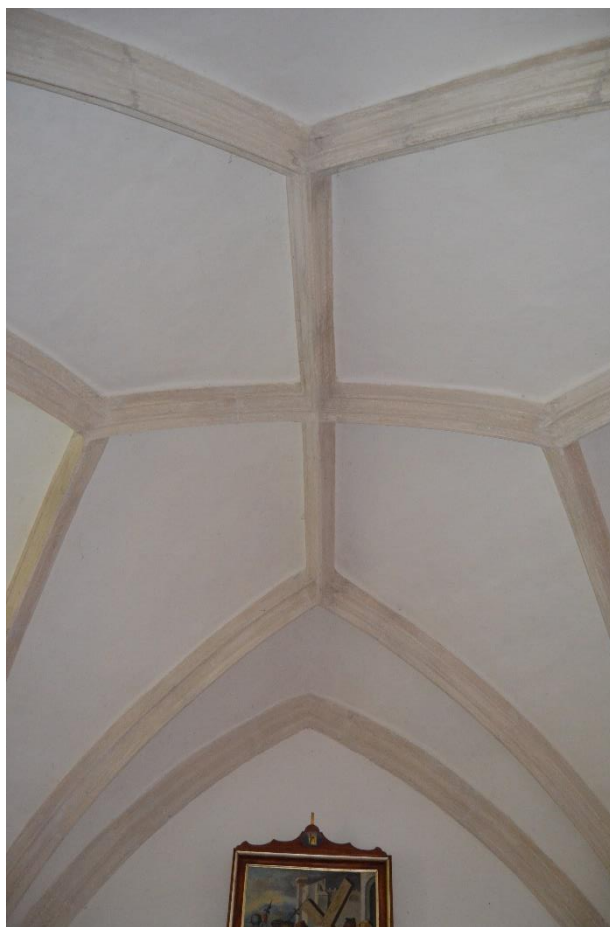
Obr. 26 – Interiér trojlodí, pohled na klenbu bočných polí kruchty.
