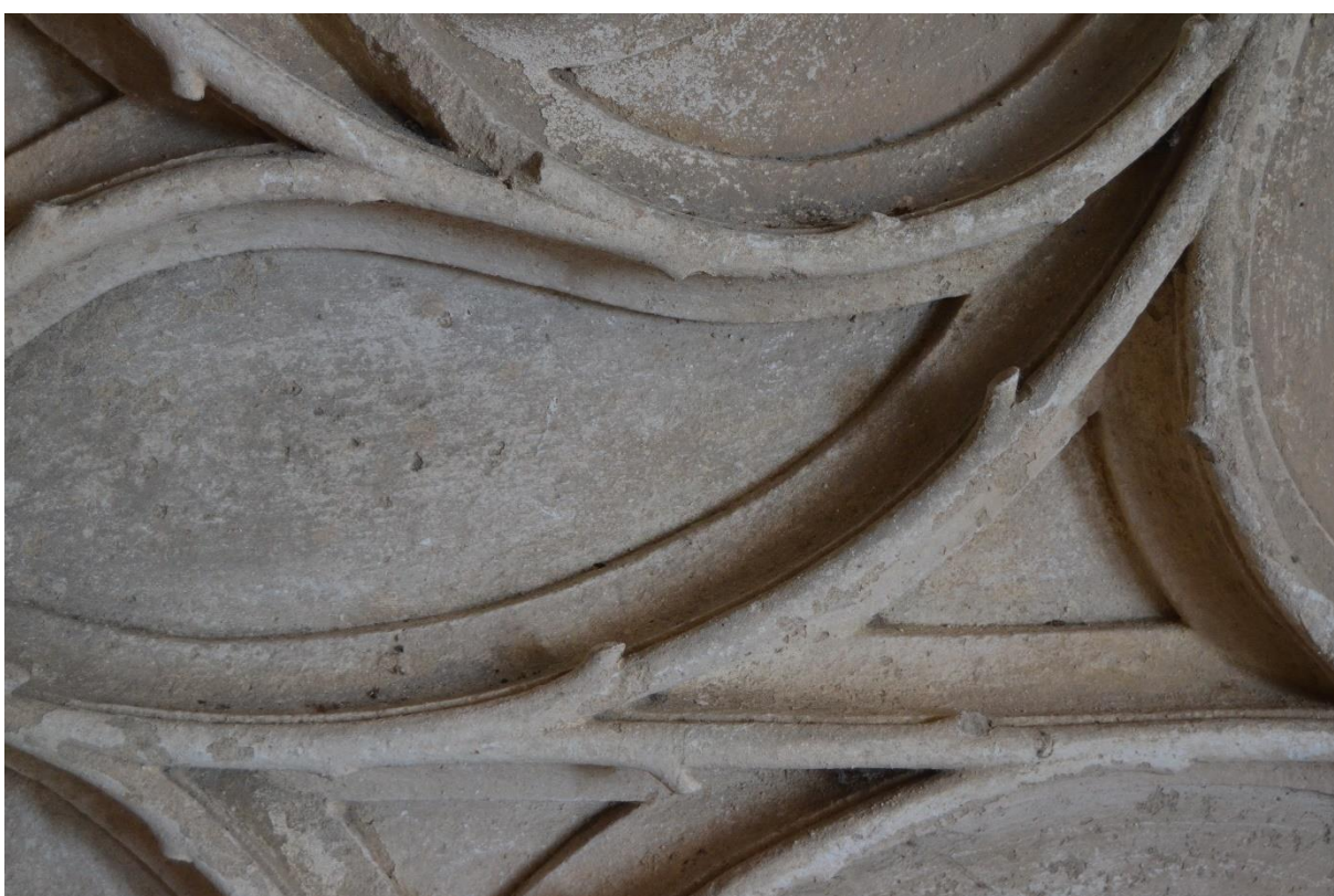
Obr. 34 – Detail kružby parapetního pásu kruchty.
