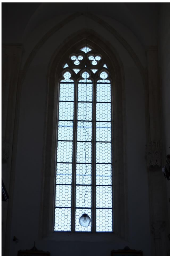
Obr. 10 – Trojlodí kostela, pohled na lomené okno.
