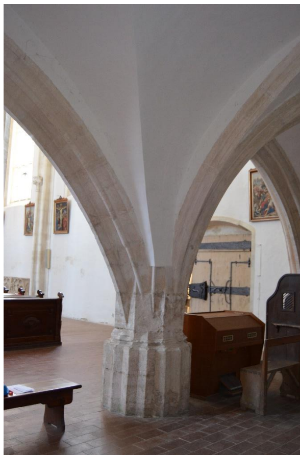
Obr. 28 – Interiér trojlodí, pohled pilíř nesoucí kruchtu.
