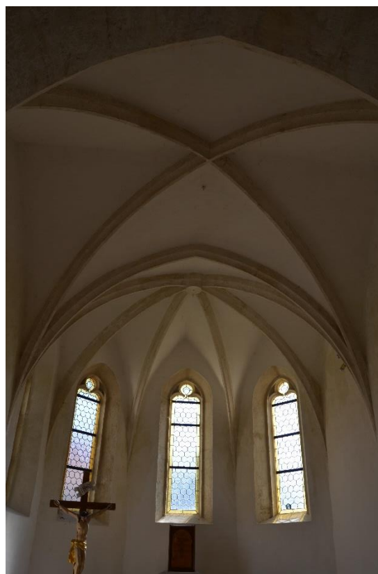
Obr. 45 – Interiér studniční kaple, pohled na klenutí presbytáře.
