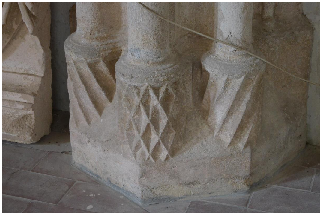
Obr. 29 – Interiér trojlodí, detail soklu přípory v podkruchtí.
