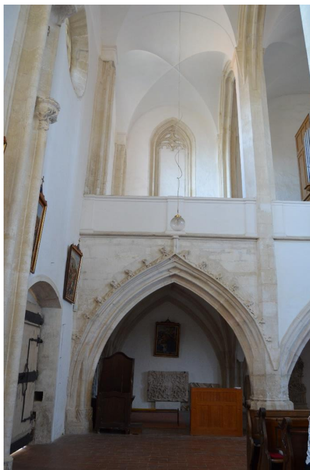
Obr. 24 – Interiér trojlodí, pohled na boční oblouk kruchty.
