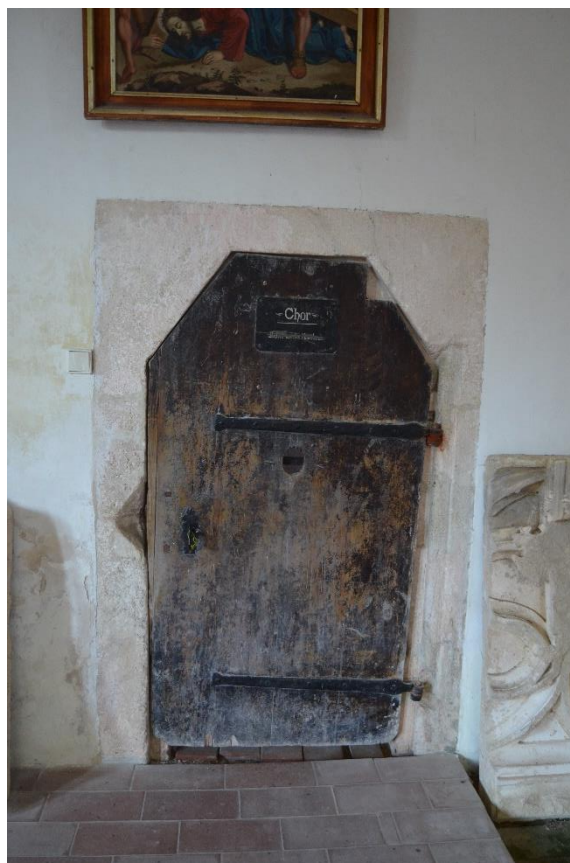
Obr. 31 – Interiér trojlodí, pohled na portál vedoucí do schodišťové šachty.
