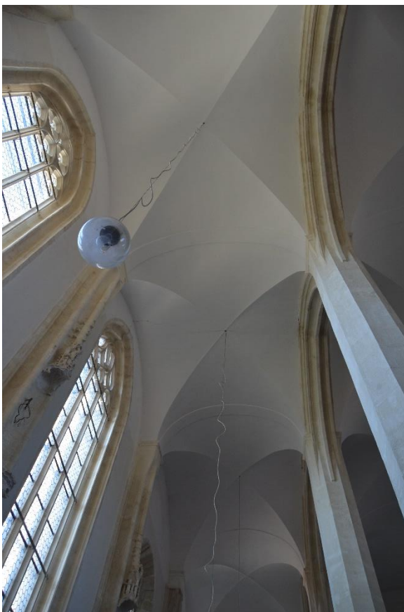
Obr. 18 – Interiér trojlodí, pohled na klenbu boční lodi.
