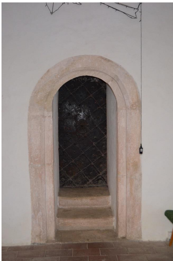
Obr. 30 – Interiér trojlodí, pohled na portál do podvěží.
