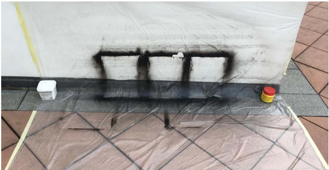
Obr. 55: Zátíší nástřiku podkladu – Windows
