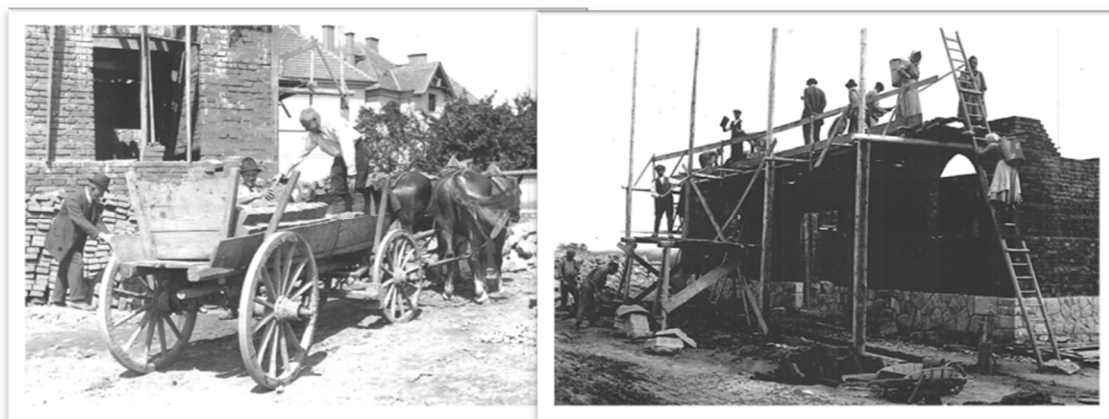
Obrázek 10. Na fotografiích z roku 1926 jsou zdokumentovány práce při výstavbě sokolovny ve Křemži. Vlevo koňský povoz přivážející materiál, vpravo zednické práce a přeprava stavebního materiálu. Kronika TJ Sokol Křemže.
