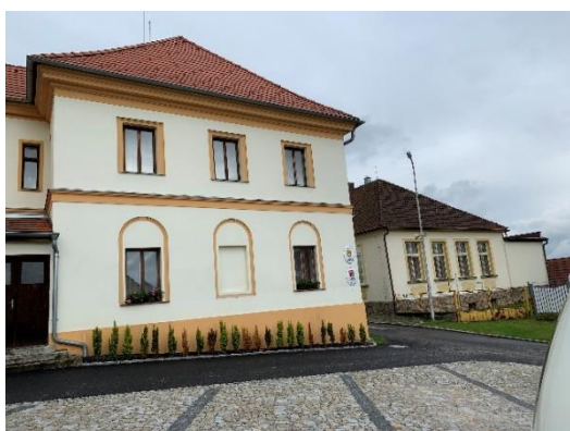
Obrázek 20: Budovy bývalých škol v Soběnově (2020)
