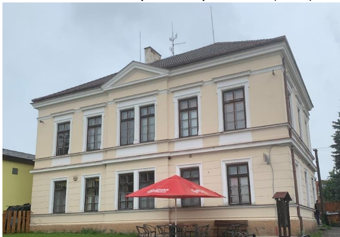
Obrázek 18: Budova bývalé školy v Bukové (2020)
