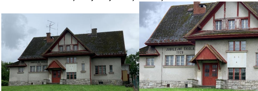
Obrázek 27: Budova bývalé jubilejní školy ve Velkých Skalinách
