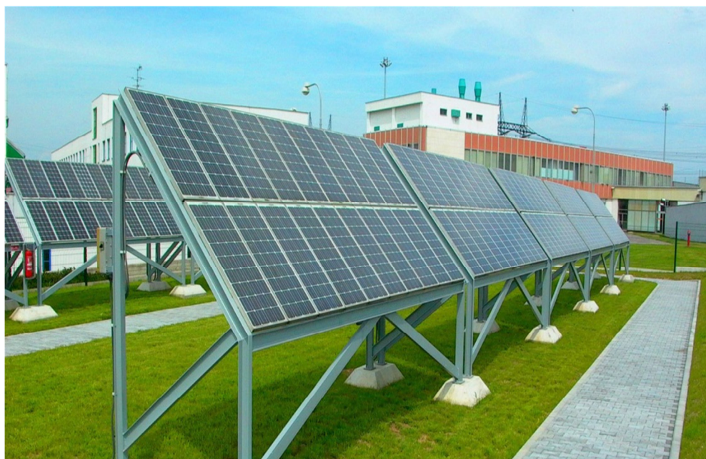
Obrázek č. 19 - První česká fotovoltaická elektrárna v Dukovanech o výkonu 10 kW – převzato z: [38]
