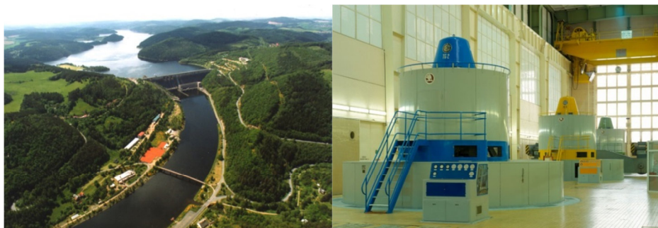
Obrázek č. 15 - Vodní elektrárna Orlik - převzato z: [34]
