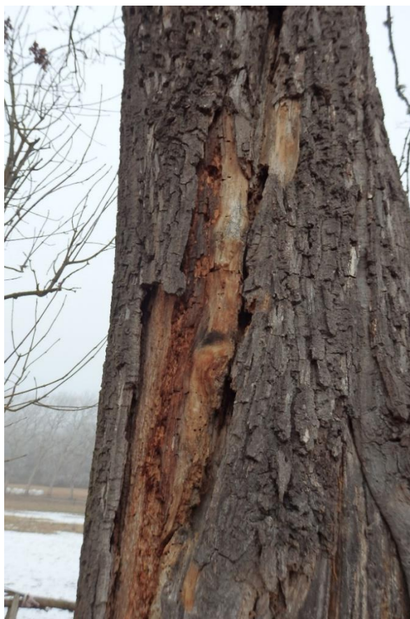
Obr. 8.28: Poškození borky dřevokazným hmyzem
