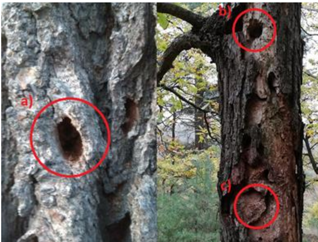
Obrázek 2. Typický strom s výletovými otvory tesaříka obrovského v NP Podyjí. Na obrázku můžeme vidět příklad starého dubu s a) výletovým otvorem tesaříka obrovského, b) výletový otvor poškozený činností šplhavců a c) typické požerky larev.
