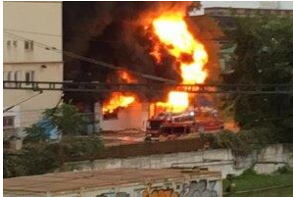
Obrázek 5 Požár skladu chemikálií ve městě Trnava. Zdroj: https://mytrnava.sme.sk/c/22221524/v-areali-trnavskeho-podniku-vvpukol-obrovsky-poziar.html
