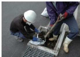
ODSTRANĚNÍ USAZENIN ZE SILNIČNÍCH PŘÍKOPŮ
