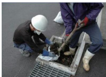
Odstranění usazenin ze silničních příkopů
