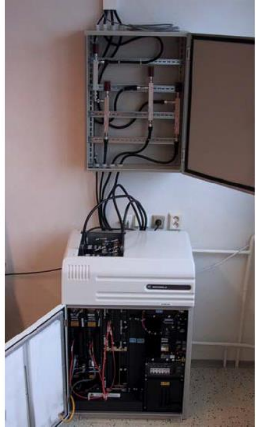
Obrázek 7: Základnová stanice EGSM (zdroj: www.motorolasolutions.com )
