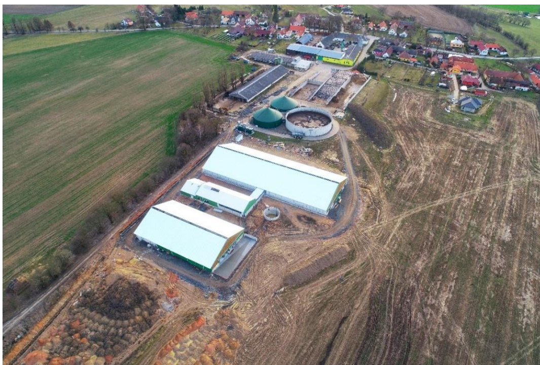
Obrázek č. 7: Letecký snímek novostavby farmy v Krátošicích
