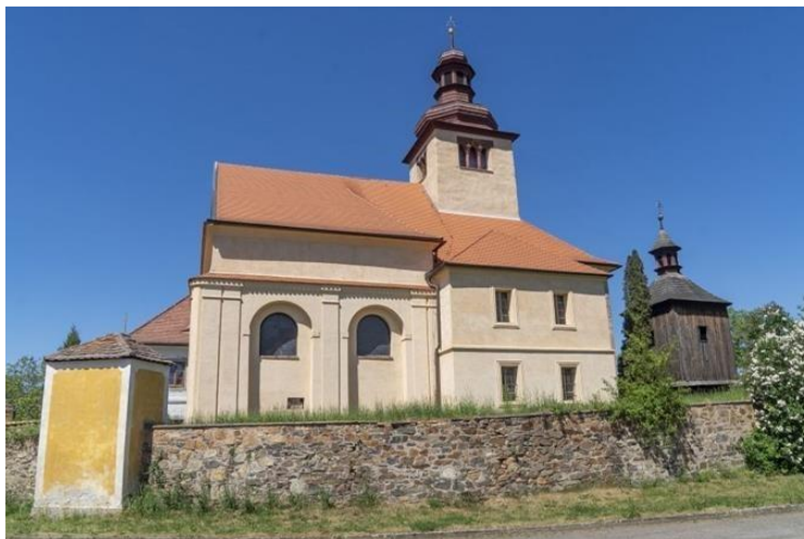
Obr. č. 8 Kostel s dřevěnou zvonicí – Záboří nad Labem (vlastní)
