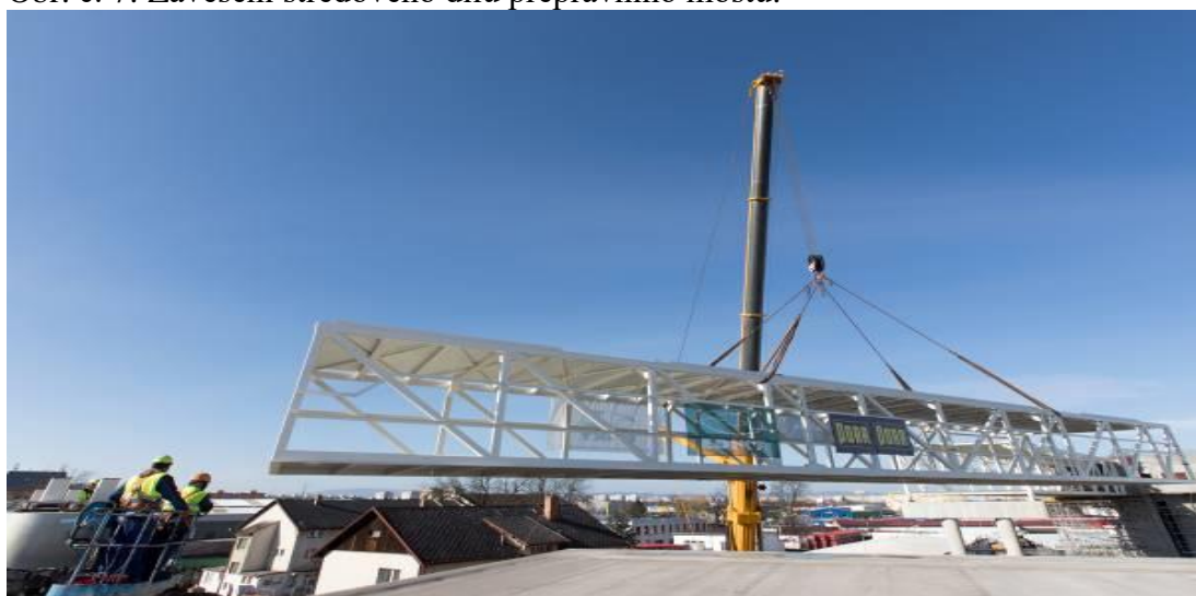
Obr. č. 7: Zavěšení středového dílu přepravního mostu.
