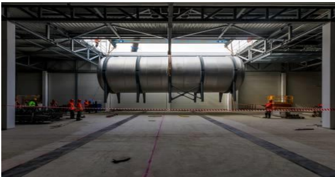
Obr. č. 11: Umístění ležáckých tanků do objektu sklepa.
