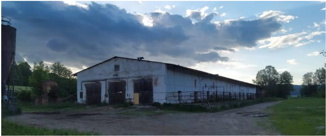
Obr. č. 29. Zemědělská stavba v Hradčanech 2020 (část 2) (Zdroj: vlastní)
