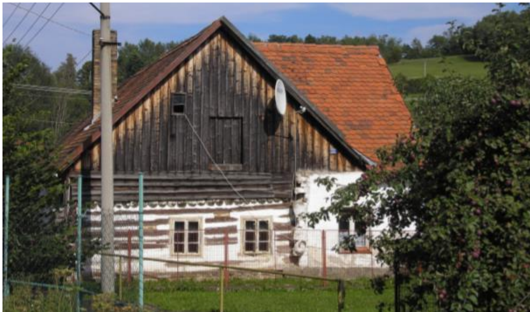
Obr. č. 18. Poslední zachovalý dřevěný dům v Bošicích 2020 (Zdroj: vlastní)
