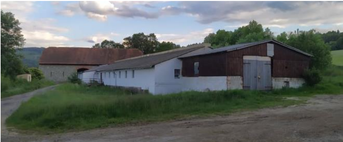
Obr. č. 28. Zemědělská stavba v Hradčanech 2020 (část 1) (Zdroj: vlastní)
