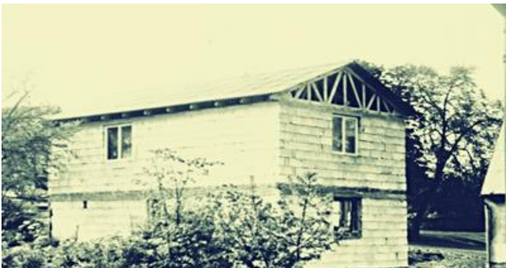
Obr. č. 13. Nově budovaný obecní úřad (1977) (Zdroj: vlastní)
