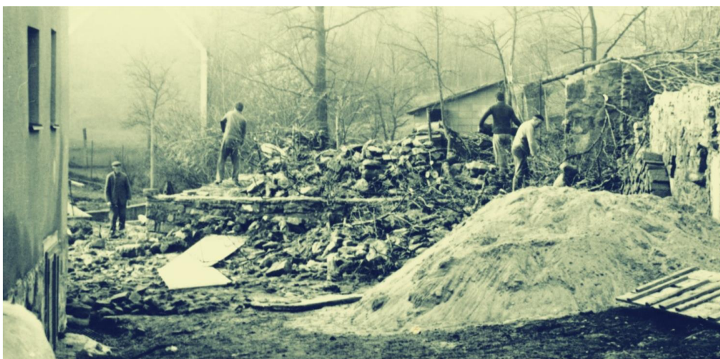
Obr. č. 12. Demolice pro novou stavbu obecního úřadu (1977) (Zdroj: vlastní)
