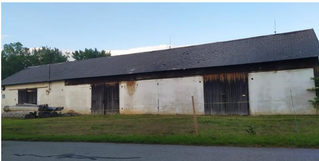
Obr. č. 26. Zemědělská stavba v Budilově 2020 (Zdroj: vlastní)
