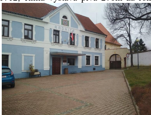
Foto autora č.24 Pohled na obecní úřad, v jehož sklepních prostorách se vařilo pivo
