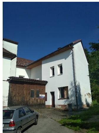
Foto autora č.19 Budova zjevně bývalého obecního pivovaru
