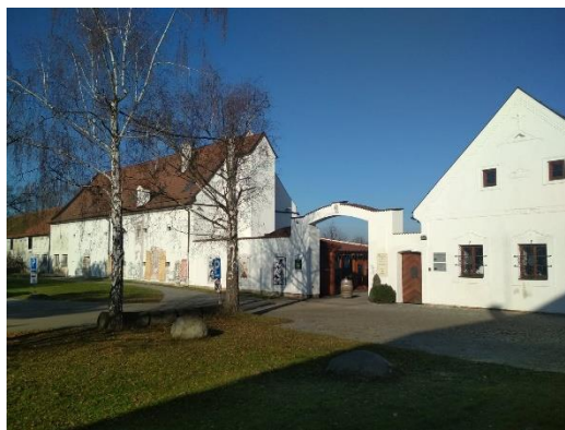
Foto autora č.9 Pohled z příjezdové cesty na přední stranu pivovaru
