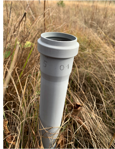
Obr. č. 7: Perforovaná trubka na trvalé ploše O1. (Foto: autor)
