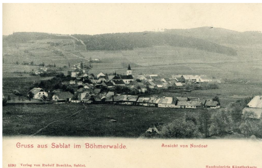
Obrázek č. 1: Pohlednice z roku 1890 (Zdroj:
