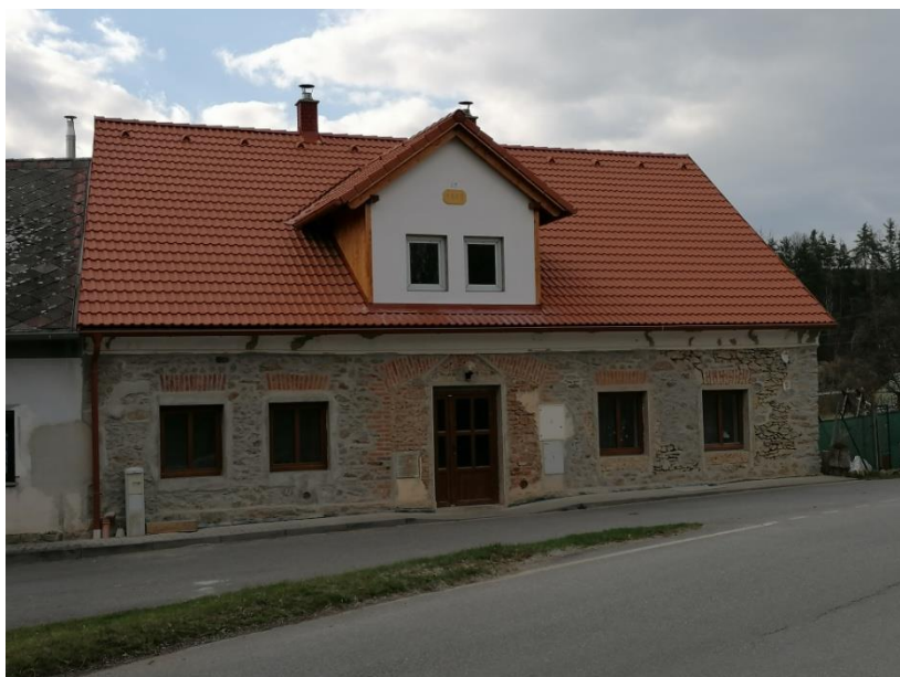
Příloha č. 12: Dům z roku 1910 procházející rekonstrukcí (Zdroj: vlastní)
